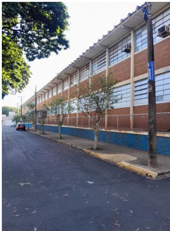
FACHADA FOTO LATERAL
