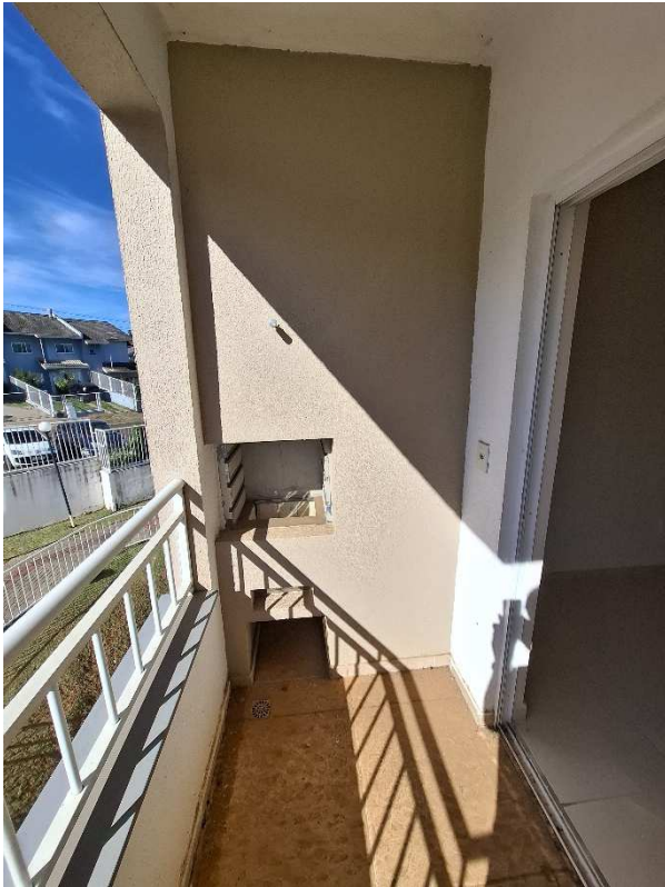
Fotografia 09 – Aspecto interno da Unidade n° 204.
