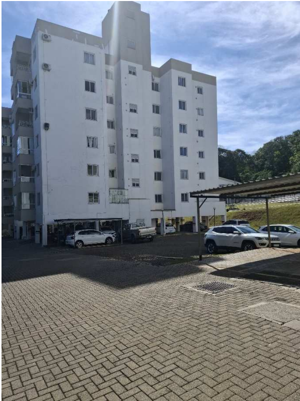
Fotografia 07 – Aspecto geral do Condomínio Residencial Baldissera.
