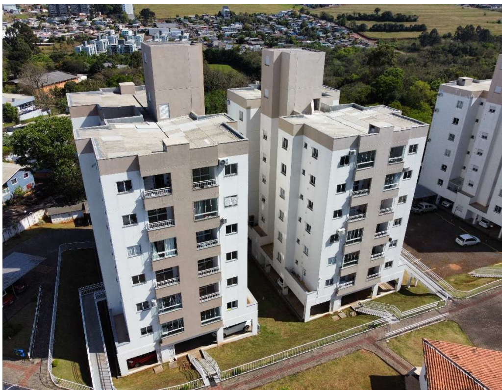
Fotografia 04 – Aspecto geral do Condomínio Residencial Baldissera.
