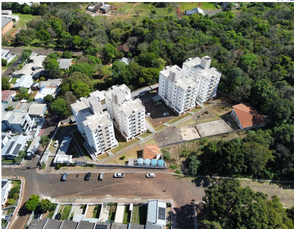
Fotografia 03 – Aspecto geral do Condomínio Residencial Baldissera.
