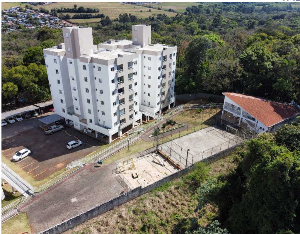
Fotografia 05 – Aspecto geral do Condomínio Residencial Baldissera.
