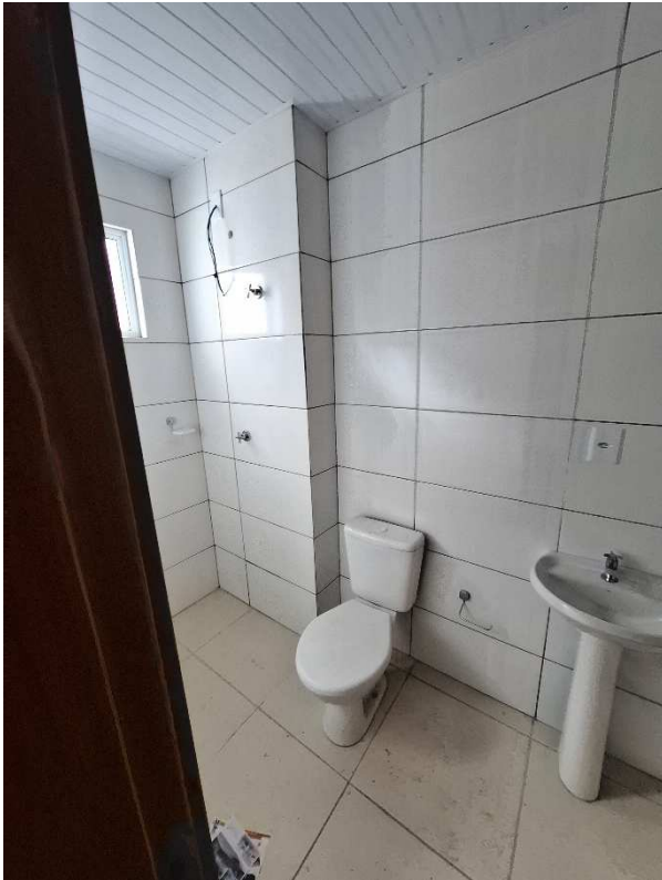
Fotografia 13 – Aspecto interno da Unidade nº 204.
