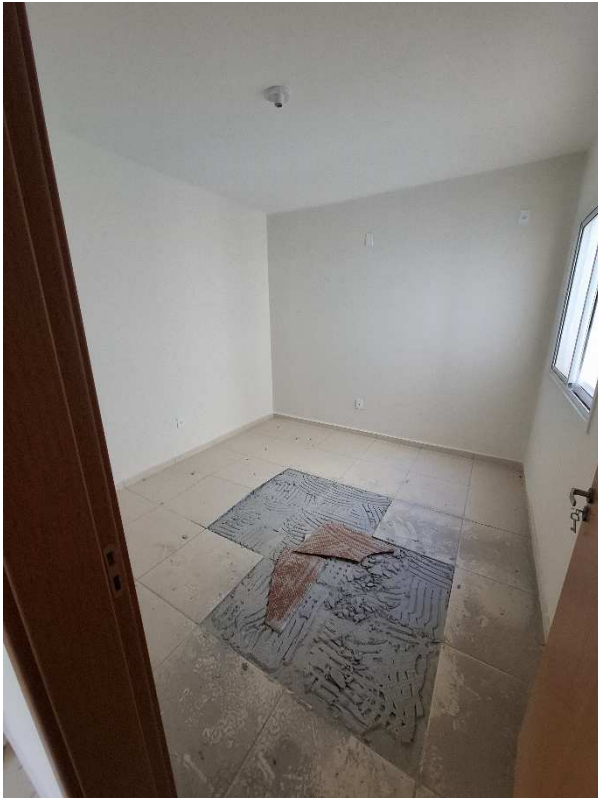
Fotografia 11 – Aspecto interno da Unidade n° 204.
