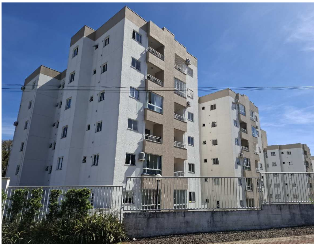
Fotografia 06 – Aspecto geral do Condomínio Residencial Baldissera.
