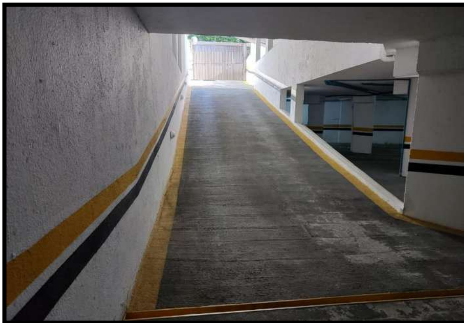
Figura 5 - Portão de veículos com rampa de acesso às garagens
