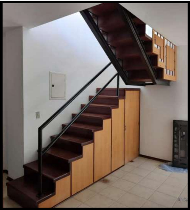
Figura 27 – Saleta de Entrada - escada de acesso a Cobertura
