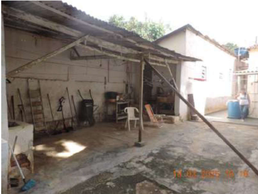
FOTO Nº 21 – VISTA INTERNA DA EDIFICAÇÃO DOS FUNDOS
