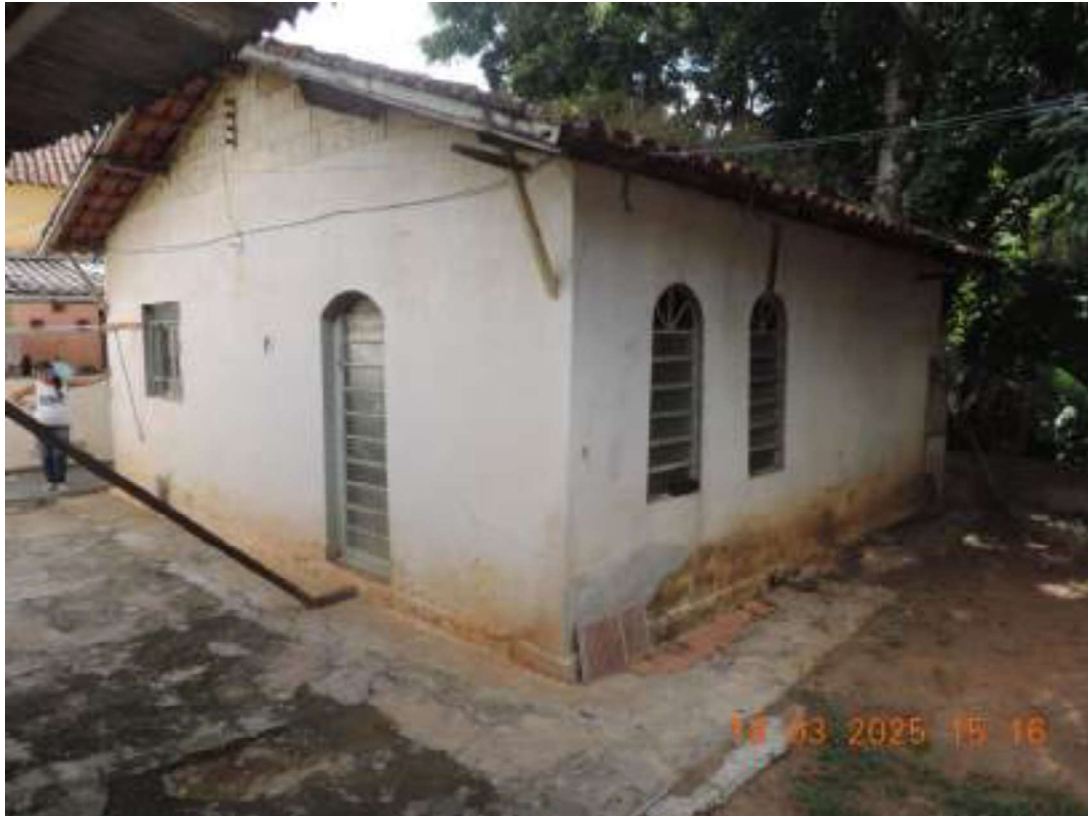
FOTO Nº 23 – VISTA EXTERNA DA EDIFICAÇÃO 2
