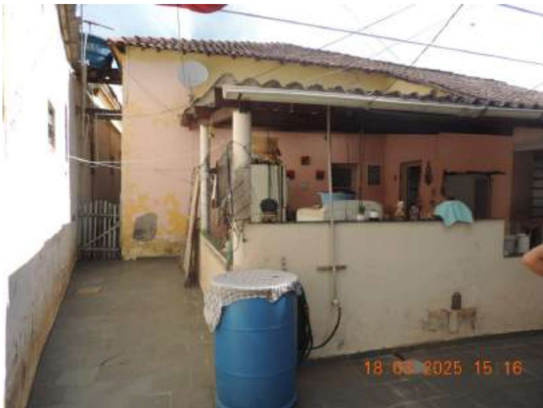
FOTO Nº 24 – VISTA EXTERNA DA EDIFICAÇÃO PRINCIPAL
