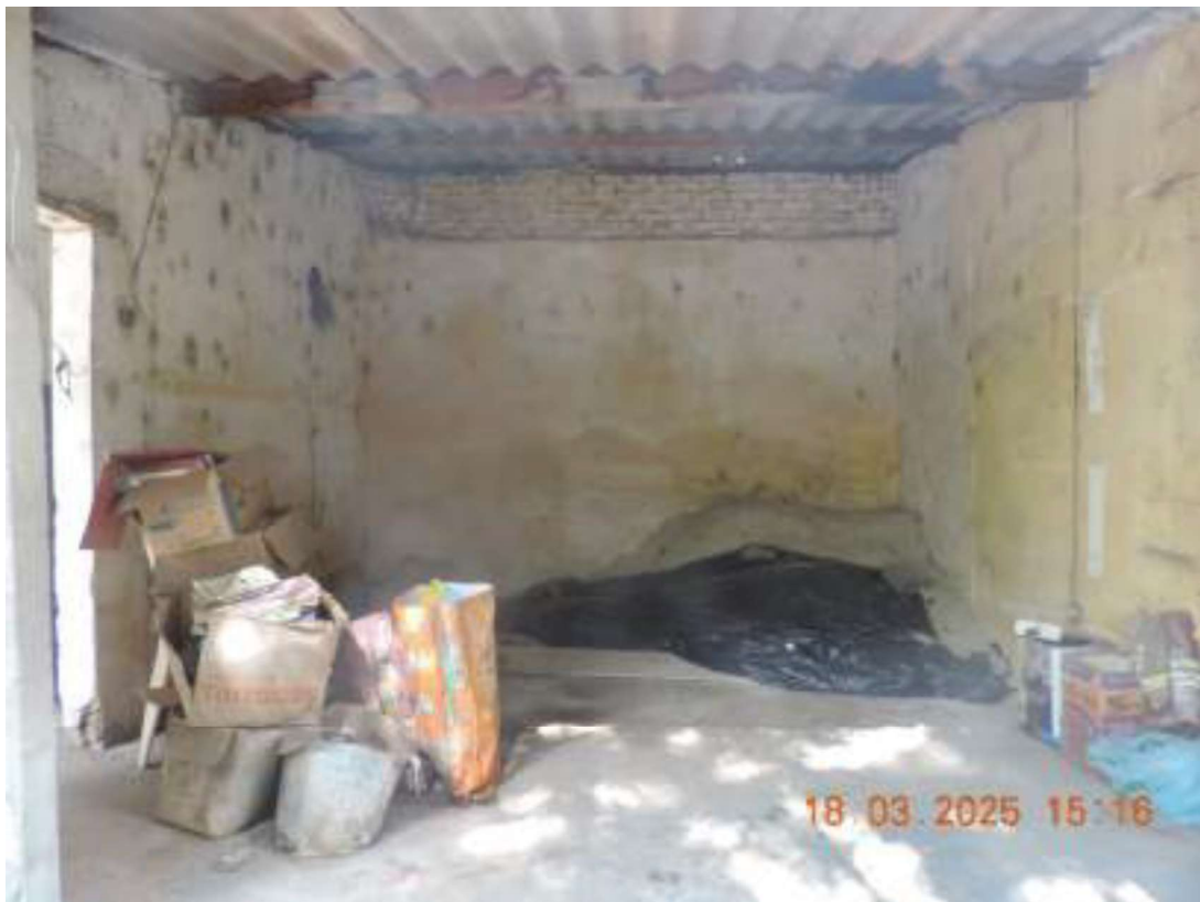
FOTO Nº 20 – VISTA INTERNA DA EDIFICAÇÃO DOS FUNDOS
