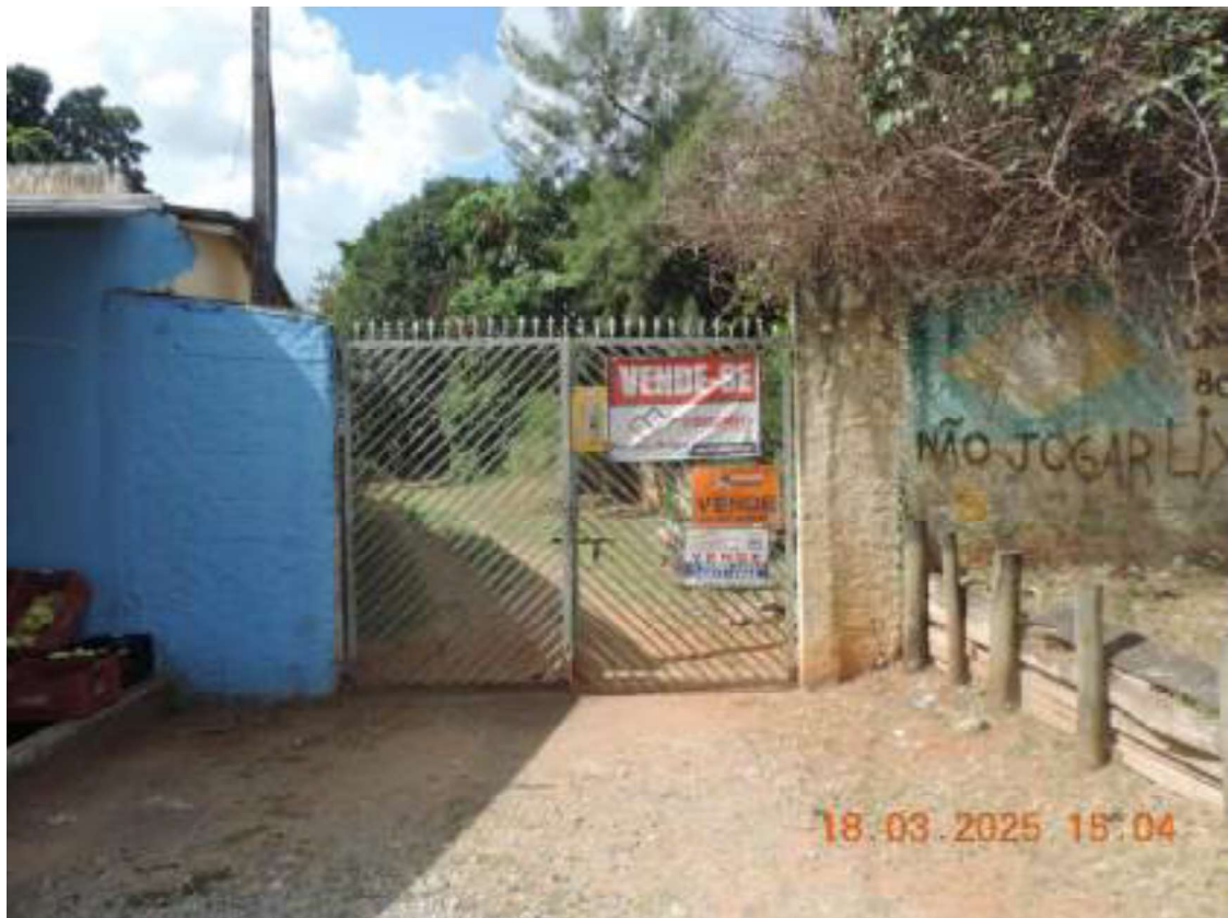
FOTO N° 12 – ACESSO NA FRENTE DO IMÓVEL (LATERAL DIREITA)
