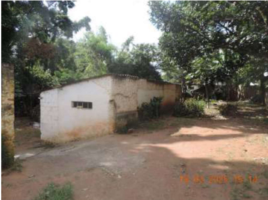
FOTO Nº 15 – VISTA EXTERNA DA EDIFICAÇÃO DOS FUNDOS (A DIREITA)
