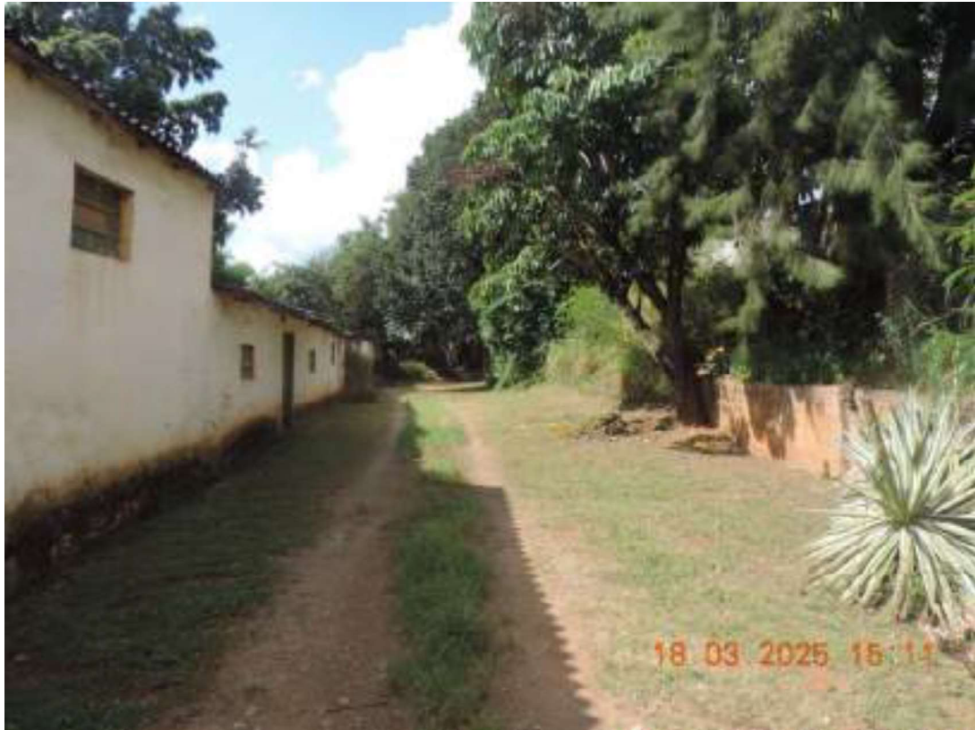
FOTO N° 13 – VISTA INTERNA DA LATERAL DIREITA DO IMÓVEL
