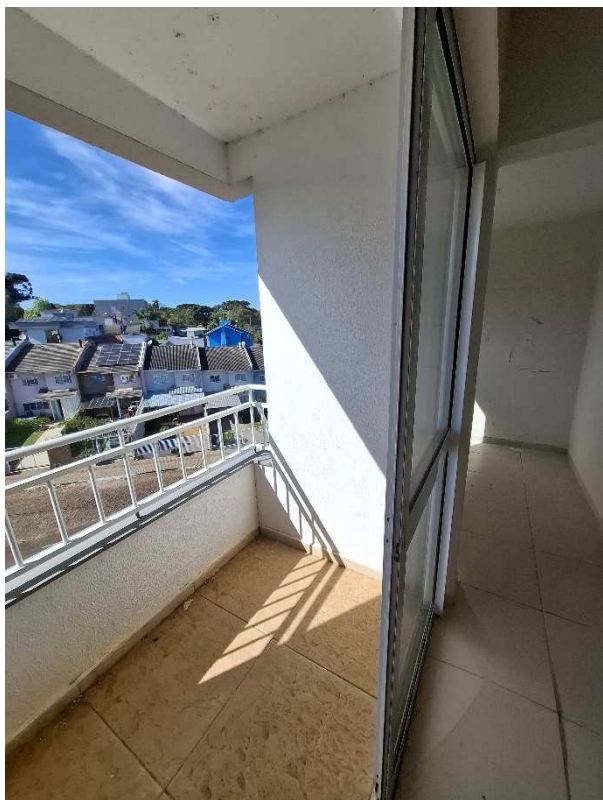
Fotografia 09 – Aspecto interno da Unidade n° 503.
