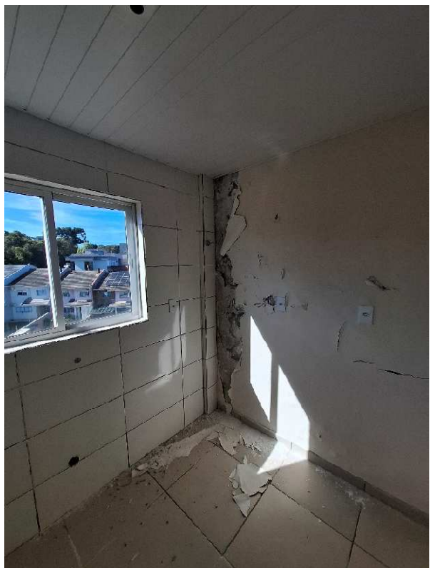
Fotografia 10 – Aspecto interno da Unidade n° 503.
