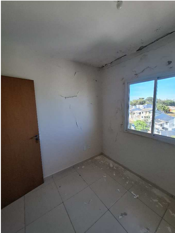
Fotografia 13 – Aspecto interno da Unidade n° 503.
