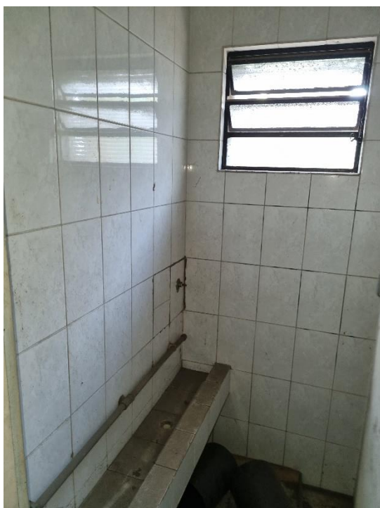
Figura 17 – WC 01 – Térreo – Fonte: Autor
