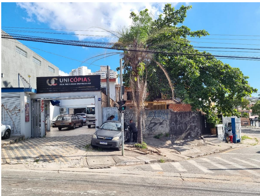
Figura 6 – Fachada do imóvel avaliando – Fonte: Autor
