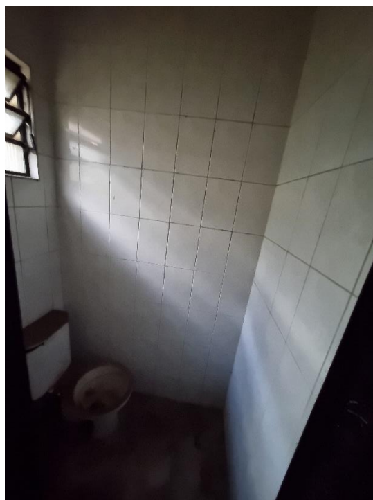
Figura 18 – WC 02 – Térreo – Fonte: Autor
