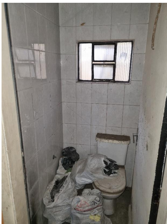
Figura 15 – WC 03 – Térreo – Fonte: Autor
