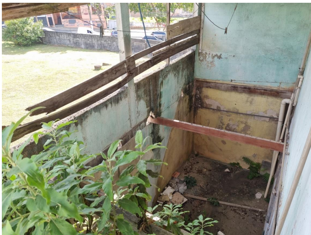
Figura 20 – Área externa fundos – Térreo – Fonte: Autor
