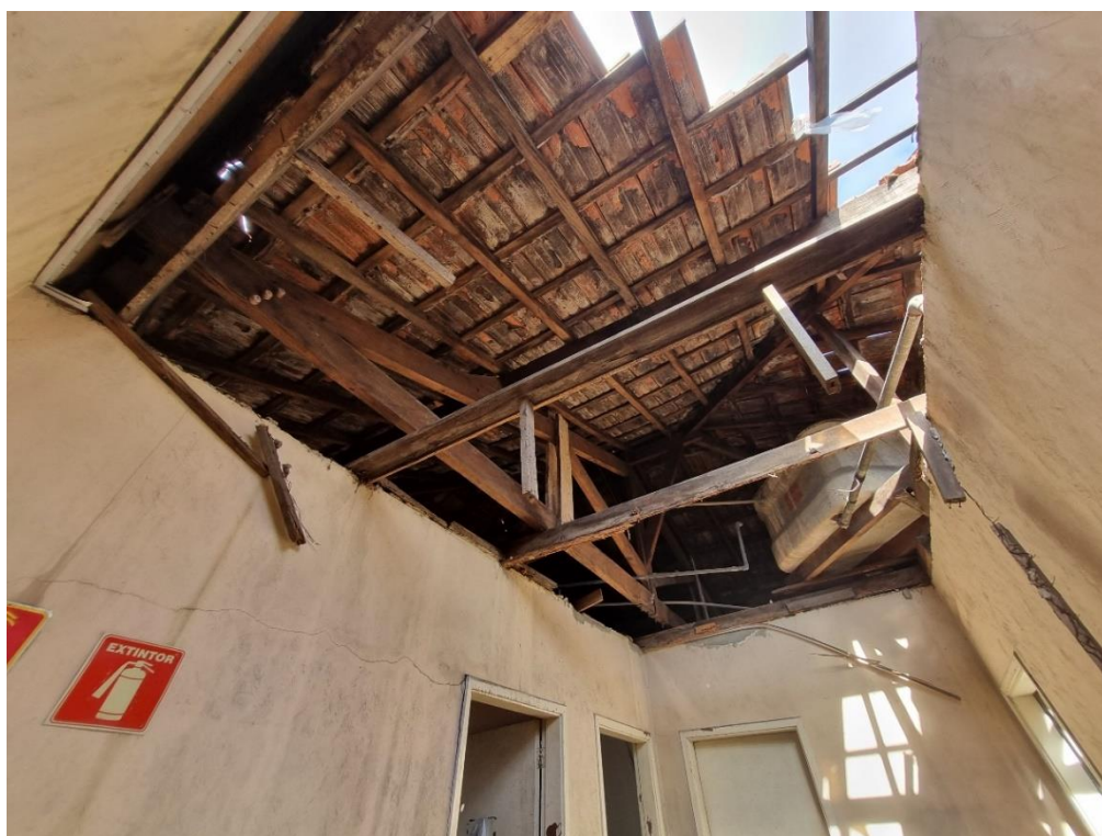
Figura 23 – Telhado circulação – 1º Pav. – Fonte: Autor
