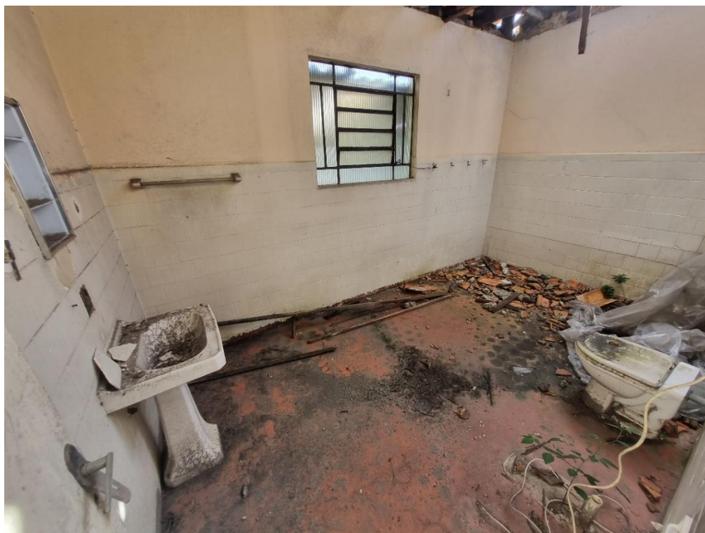
Figura 27 – Banheiro – 1º Pav. – Fonte: Autor
