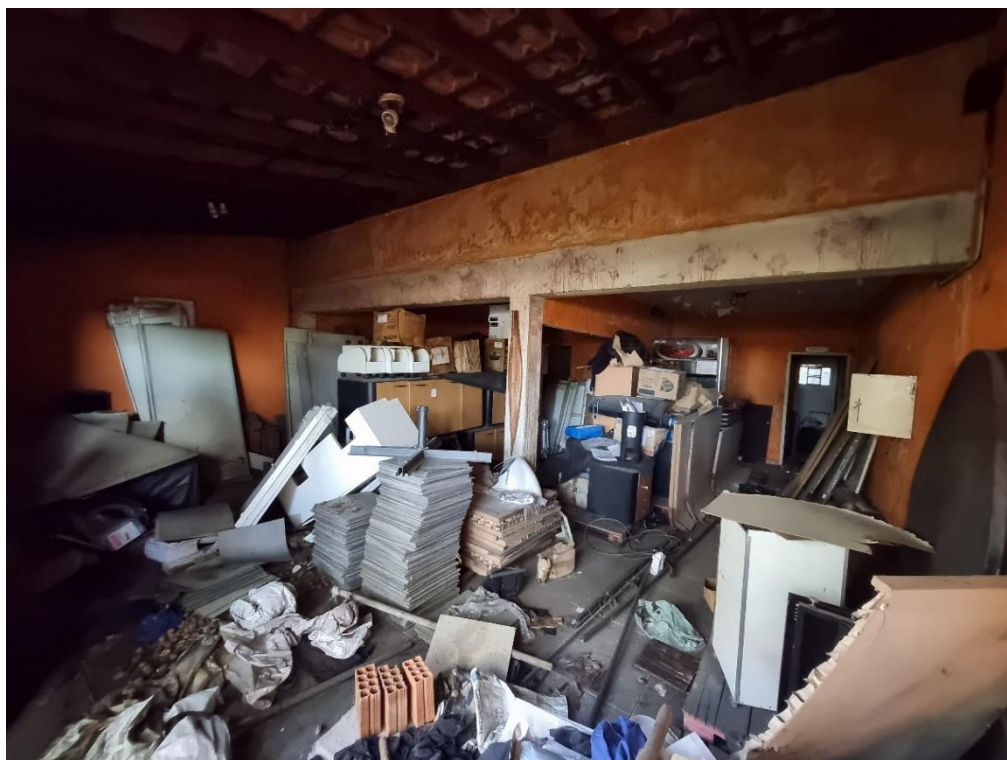
Figura 10 – Salão principal – Térreo – Fonte: Autor
