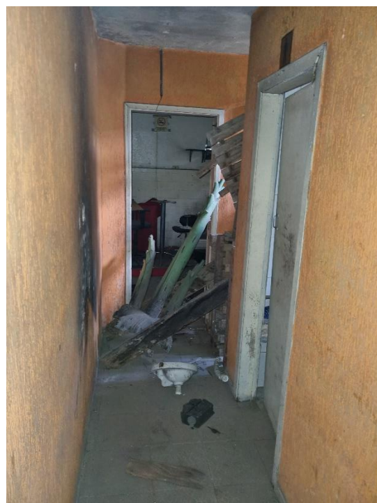
Figura 16 – Circulação - Térreo – Fonte: Autor
