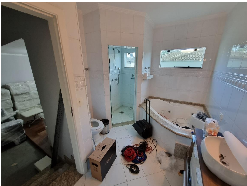
Figura 29 – Banho 02 - 1º Pav. - Fonte: Autor
