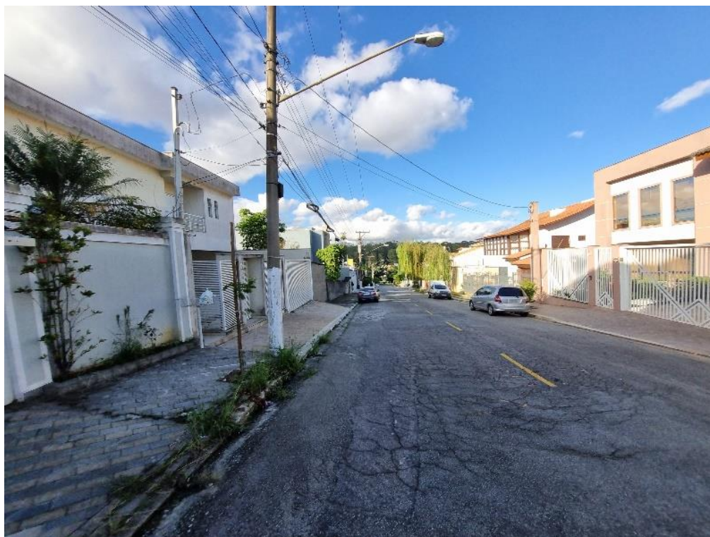
Figura 8 – Rua das Graúnas sentido Rua dos Rouxinóis – Fonte: Autor
