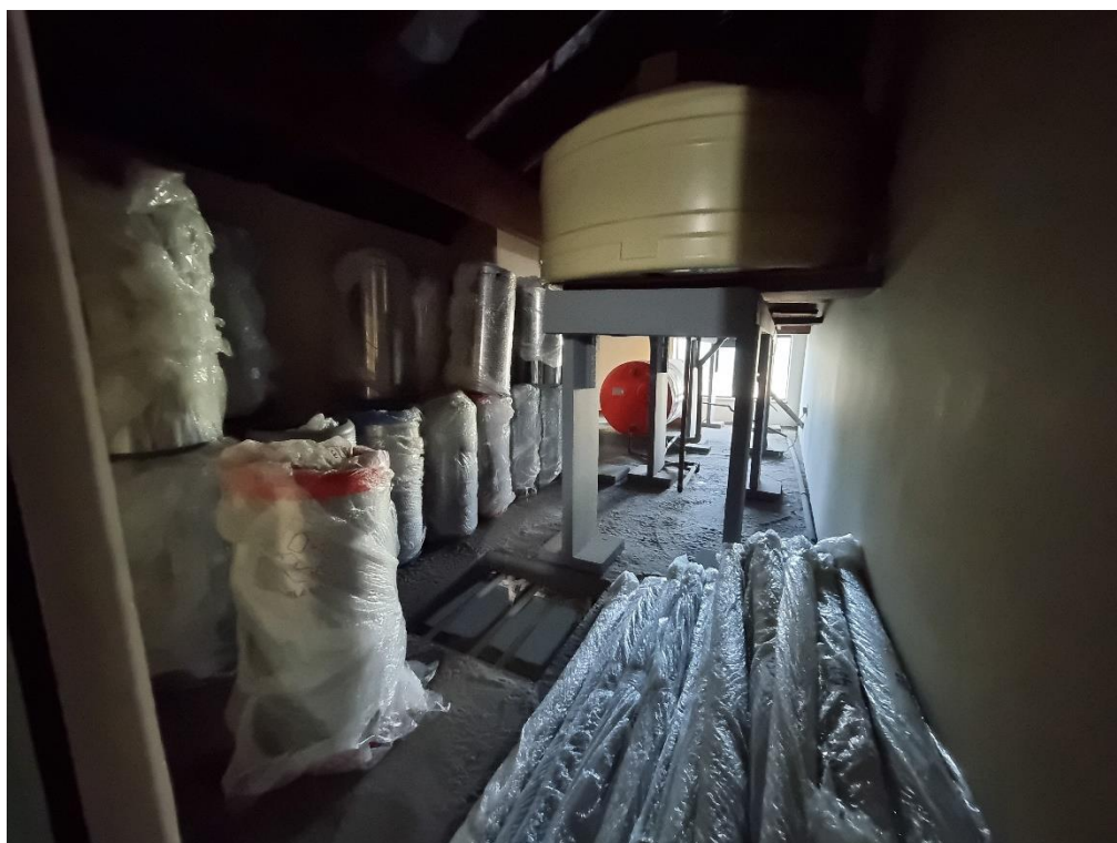
Figura 34 – Sótão 01 - 2º Pav. - Fonte: Autor
