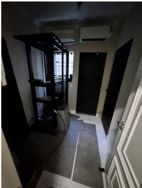
Figura 17 – Sala 04 - Térreo - Fonte: Autor
