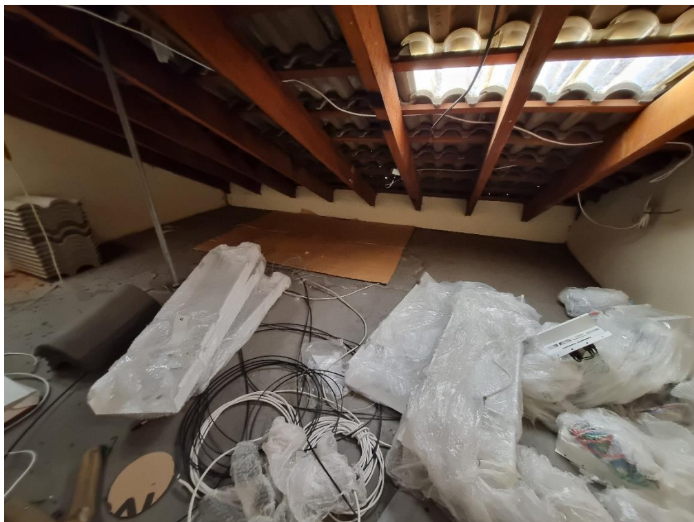
Figura 33 – Sótão 02 - 2º Pav. - Fonte: Autor
