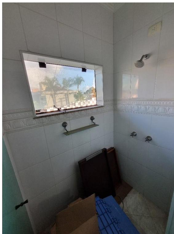
Figura 23 – Banho 03 - 1º Pav. - Fonte: Autor
