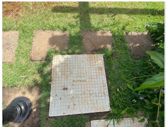
10- Quadro de energia
