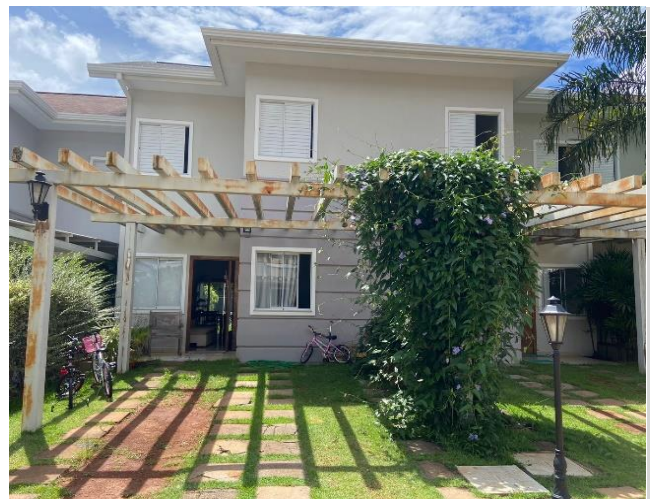
06- Fachada do avaliando
