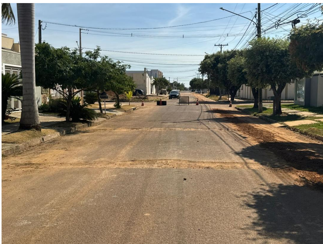
Figura 7: Registro da Rua Sicília lado direito do imóvel avaliado sentido Avenida das Figueiras Data: 20/06/2024 Fonte: Autora
