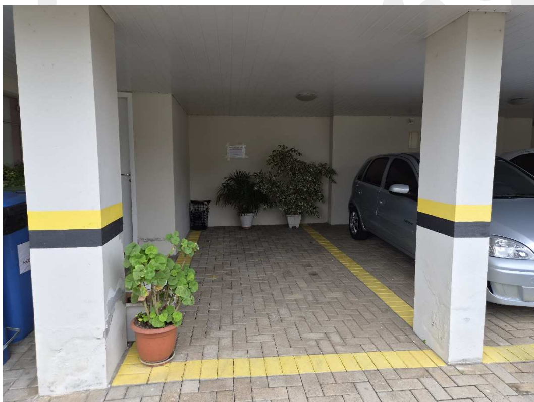
Fotografia 04 – Aspecto da Vaga de Garagem n° 16.
