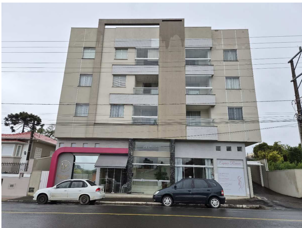
Fotografia 03 – Aspecto do Condomínio Residencial e Comercial Portinari junto ao alinhamento da Rua Pastor George Weger.
