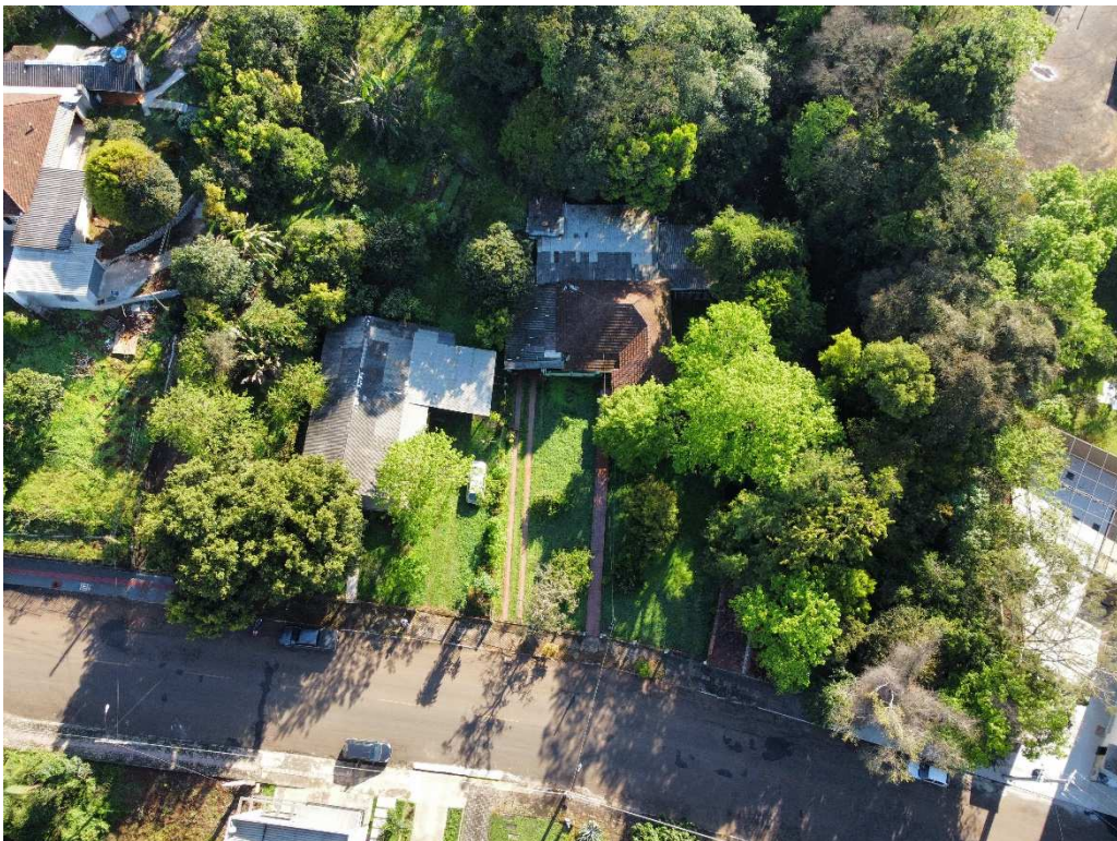
Fotografia 04 – Aspecto geral do imóvel avaliado.
