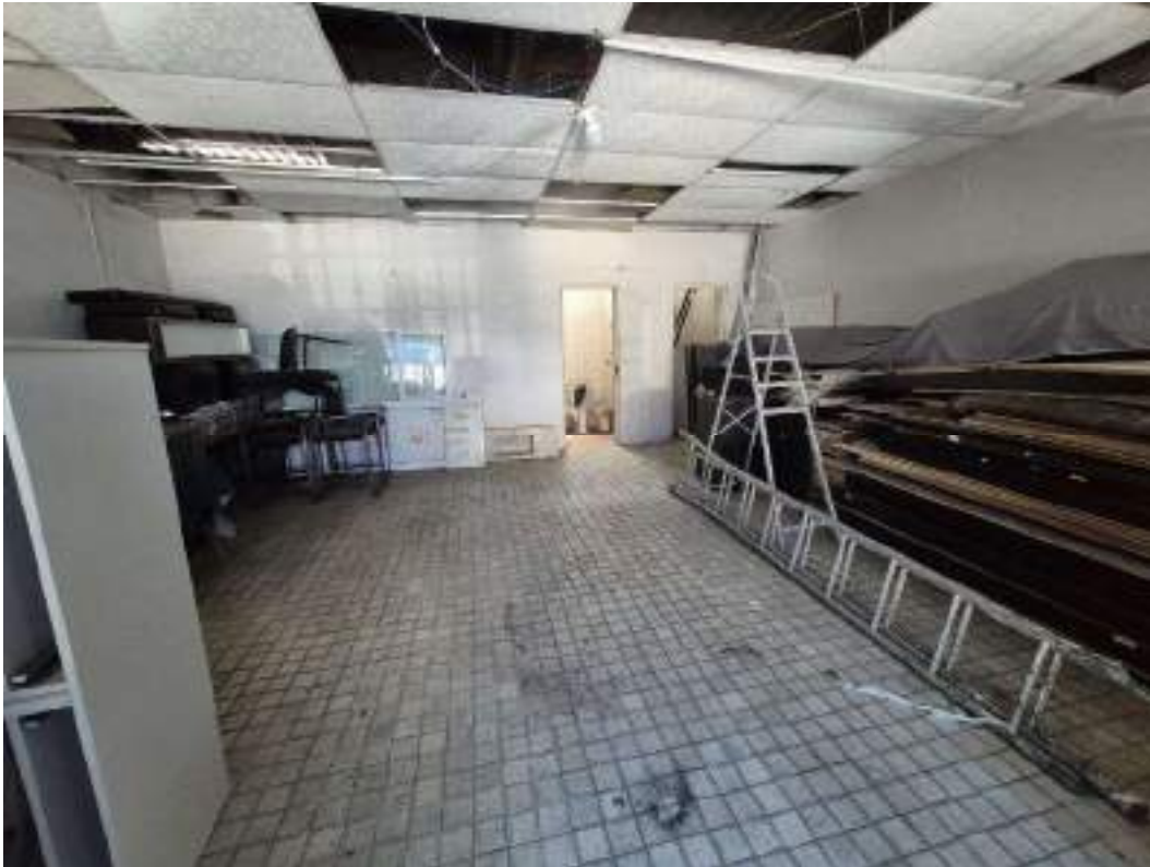
Fotografia 48 – Aspecto interno do imóvel avaliado (prédio comercial).
