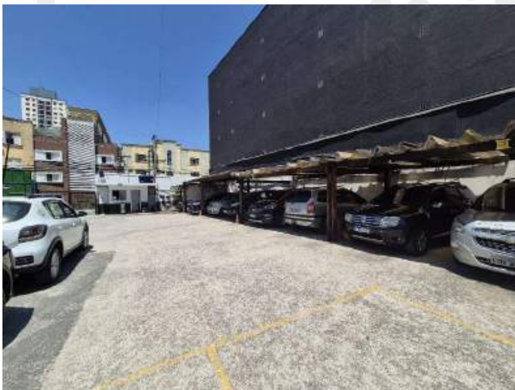
Fotografia 19 – Aspecto da área externa do imóvel avaliado (estacionamento).
