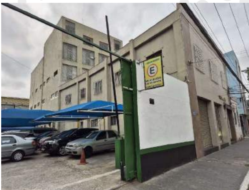
Fotografia 09 – Aspecto externo das construções existentes (Prédio Comercial).
