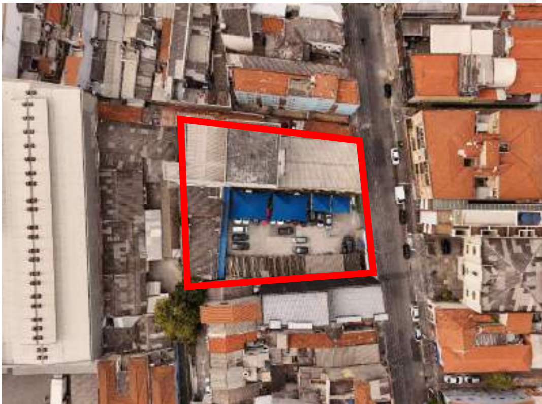
Fotografia 03 – Aspecto do imóvel avaliado (limites em vermelho) junto ao alinhamento da Rua do Hipódromol.
