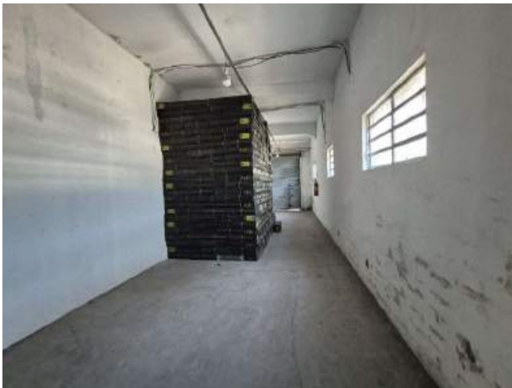
Fotografia 32 – Aspecto interno do imóvel avaliado (prédio comercial).
