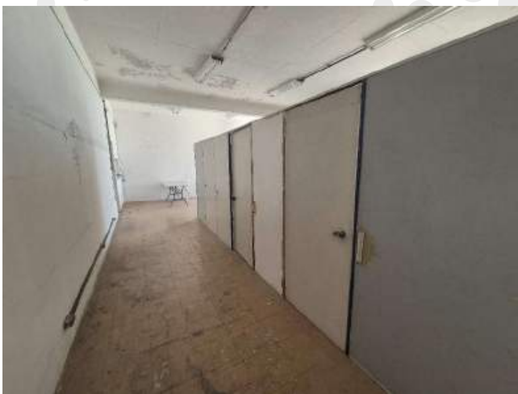
Fotografia 43 – Aspecto interno do imóvel avaliado (prédio comercial).
