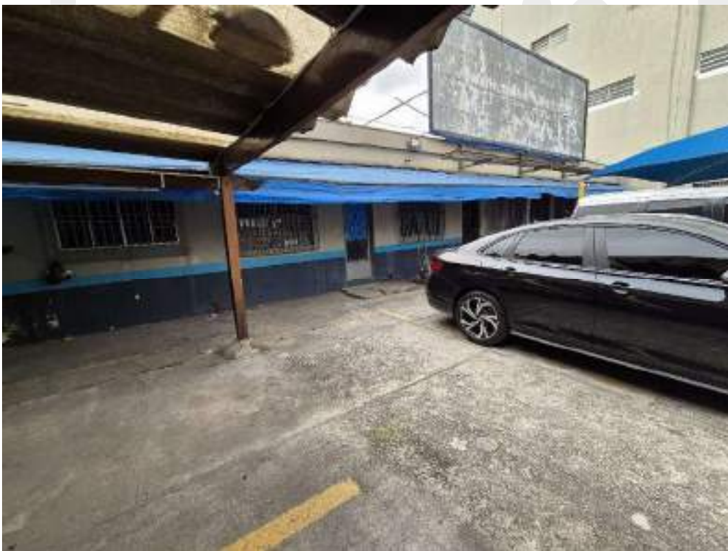
Fotografia 13 – Parte da área agregada ao prédio comercial junto ao estacionamento de veículos.
