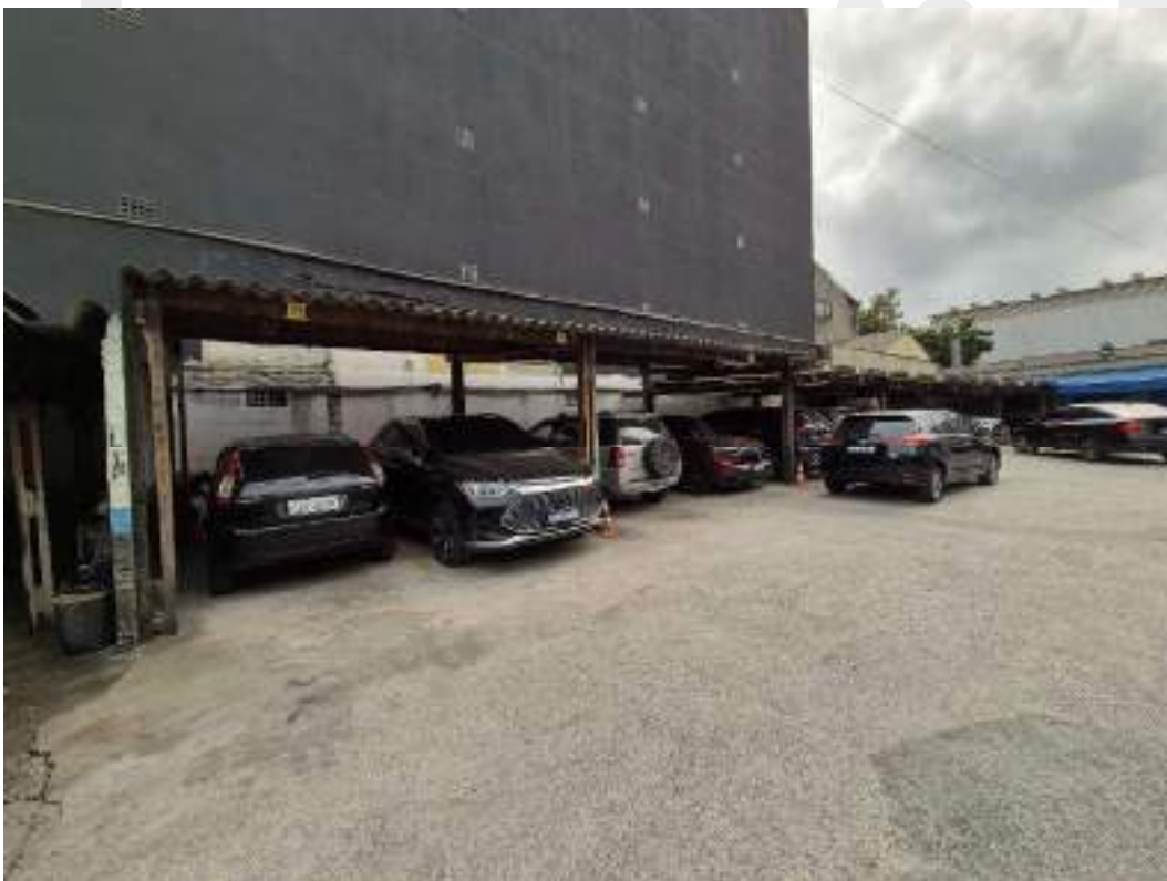
Fotografia 11 – Aspecto externo das construções existentes (Coberturas Estacionamento).
