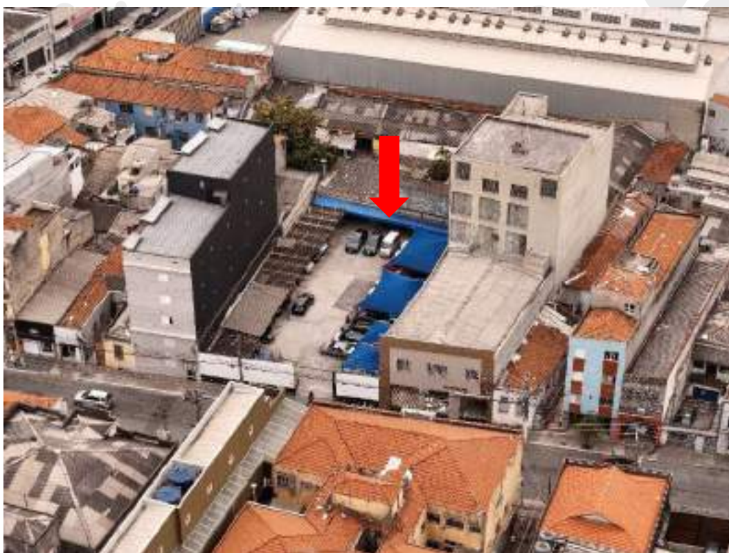
Fotografia 05 – Aspecto geral externo do imóvel avaliado, indicado pela seta vermelha.
