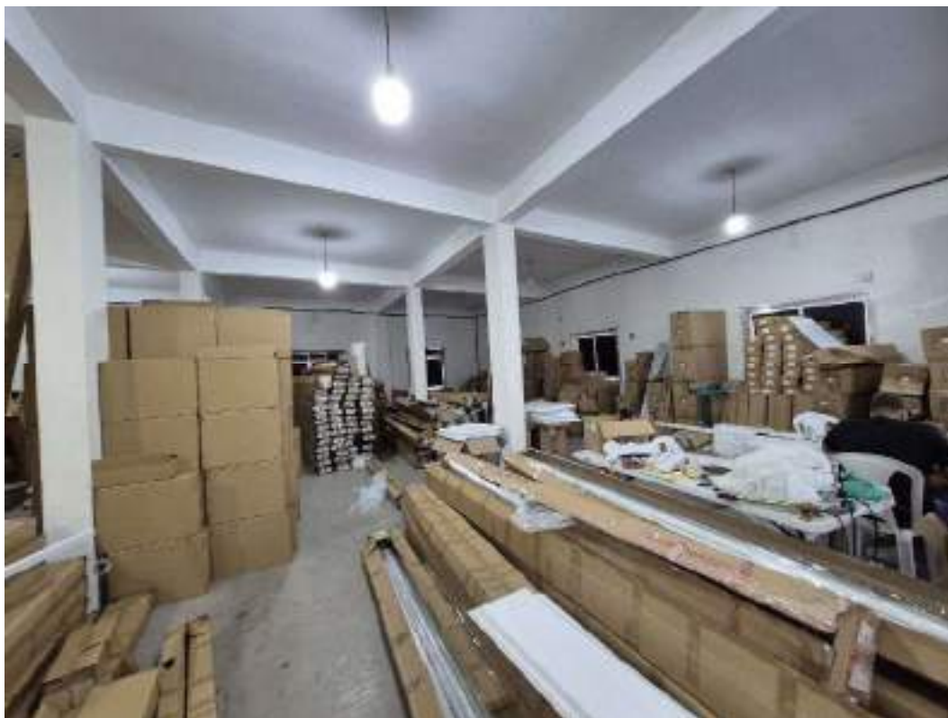
Fotografia 24 – Aspecto interno do imóvel avaliado (prédio comercial).
