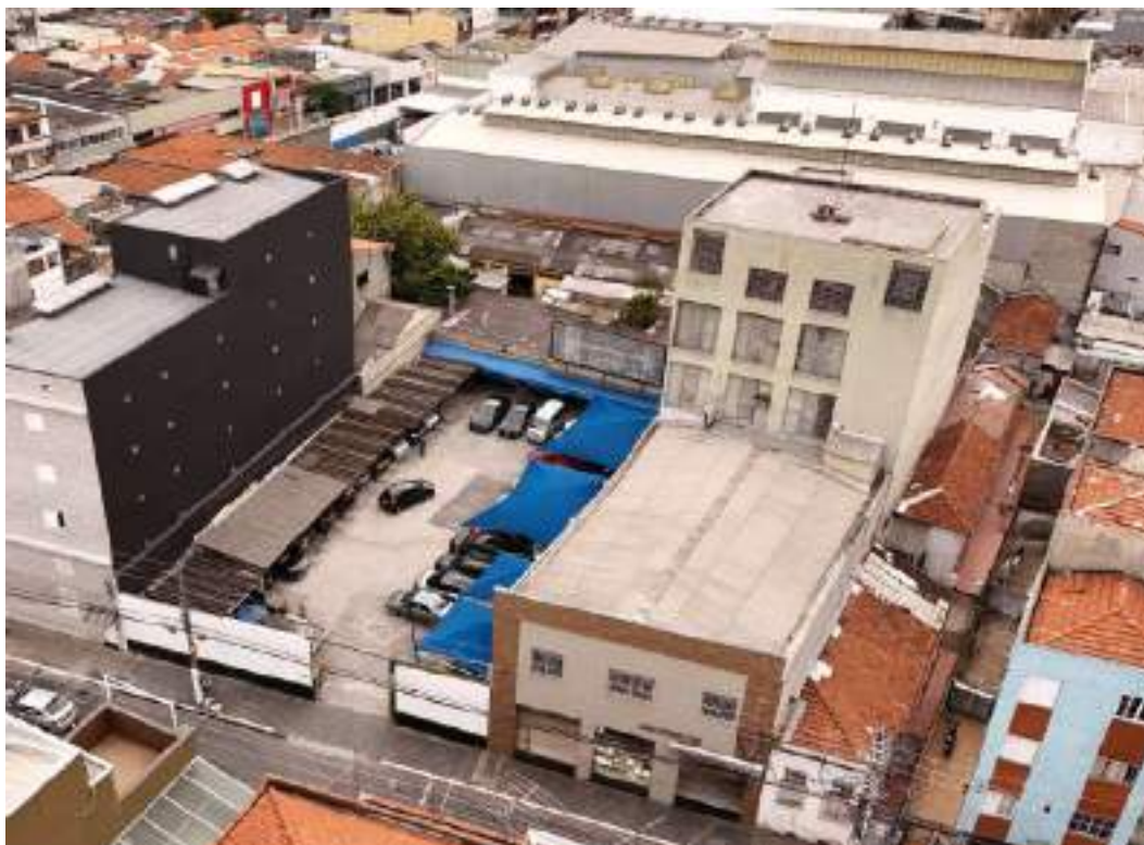
Fotografia 04 – Outro aspecto do imóvel avaliado junto ao alinhamento da Rua do Hipódromo.
