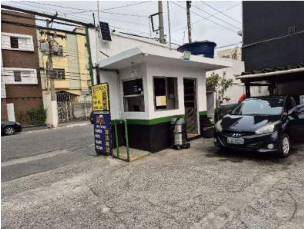
Fotografia 10 – Aspecto externo das construções existentes (Portaria).
