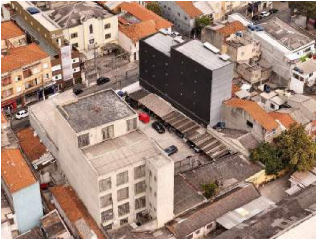
Fotografia 16 – Aspecto do imóvel avaliado visto pelos fundos.
