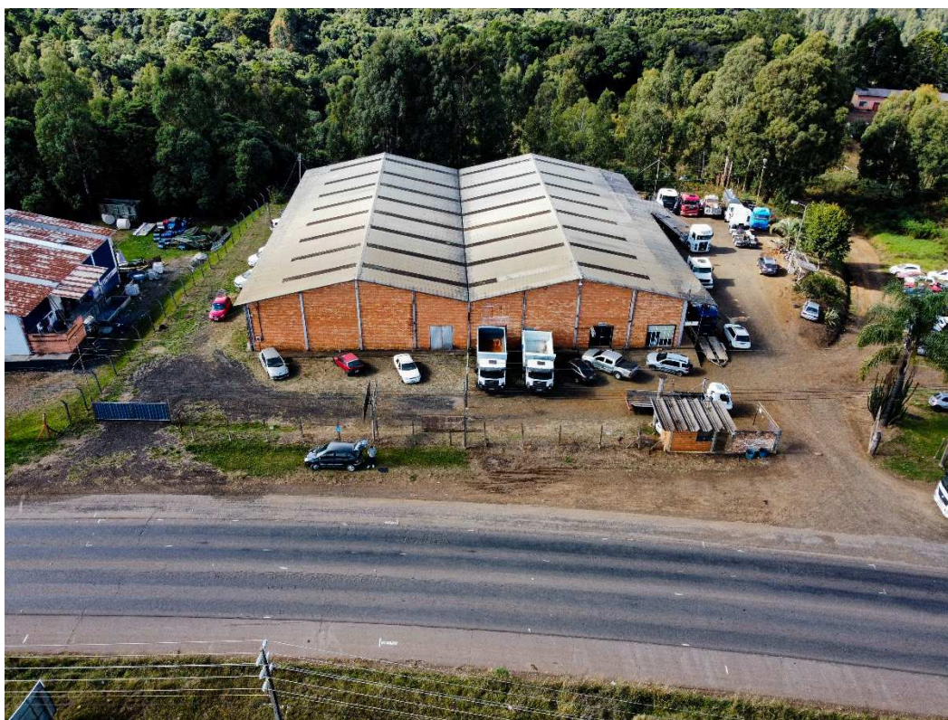
Fotografia 08 – Aspecto geral do imóvel avaliado e das construções existentes.
