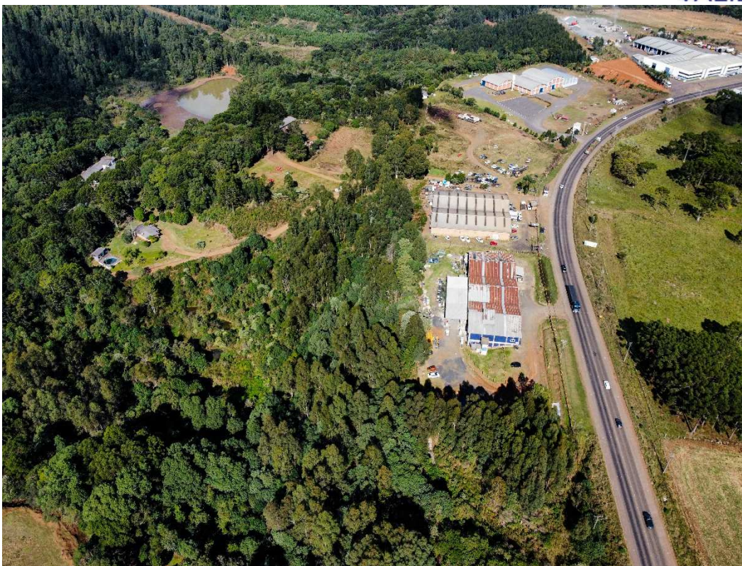
Fotografia 05 – Aspecto geral do imóvel avaliado.
