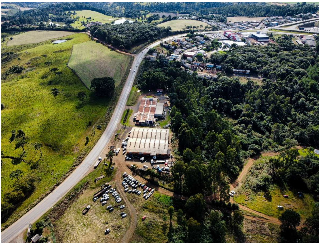
Fotografia 04 – Aspecto geral do imóvel avaliado.
