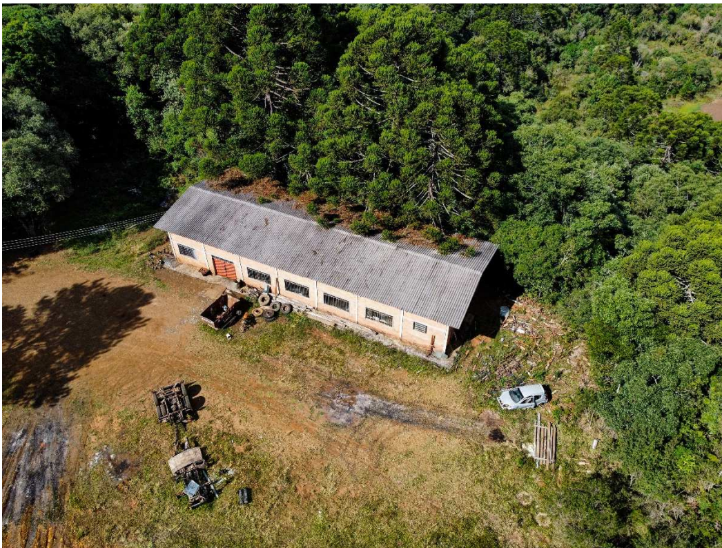
Fotografia 10 – Aspecto geral do imóvel avaliado e das construções existentes.
