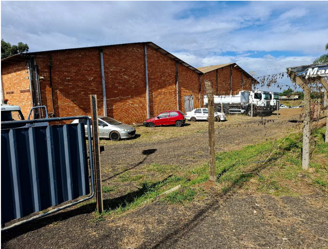
Fotografia 17 – Aspecto externo da Edificação nº 03.
