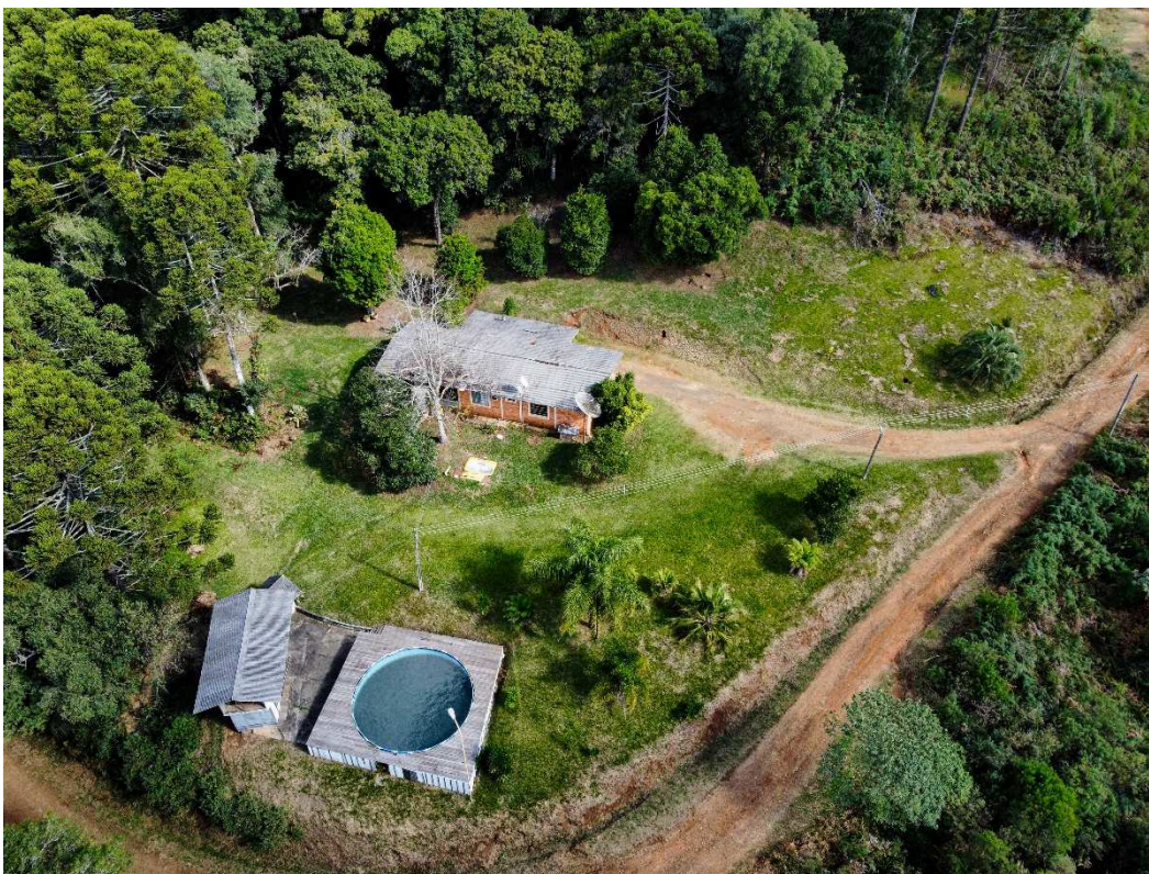
Fotografia 12 – Aspecto geral do imóvel avaliado e das construções existentes.
