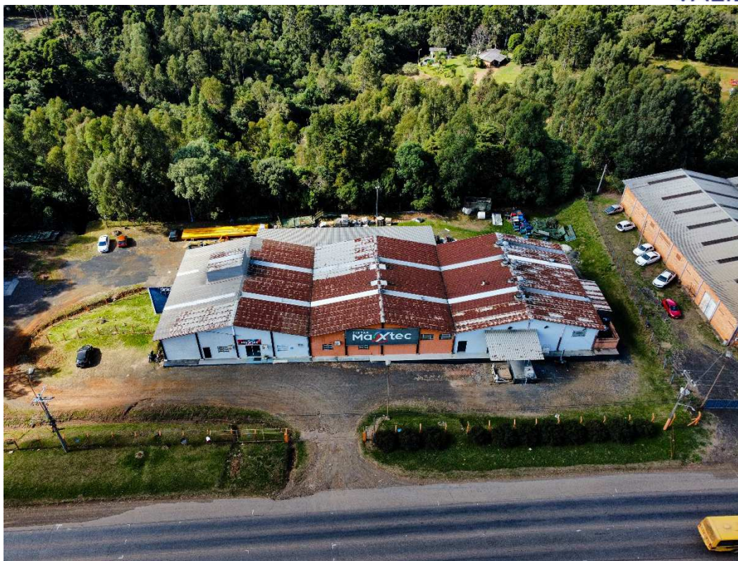
Fotografia 07 – Aspecto geral do imóvel avaliado e das construções existentes.
