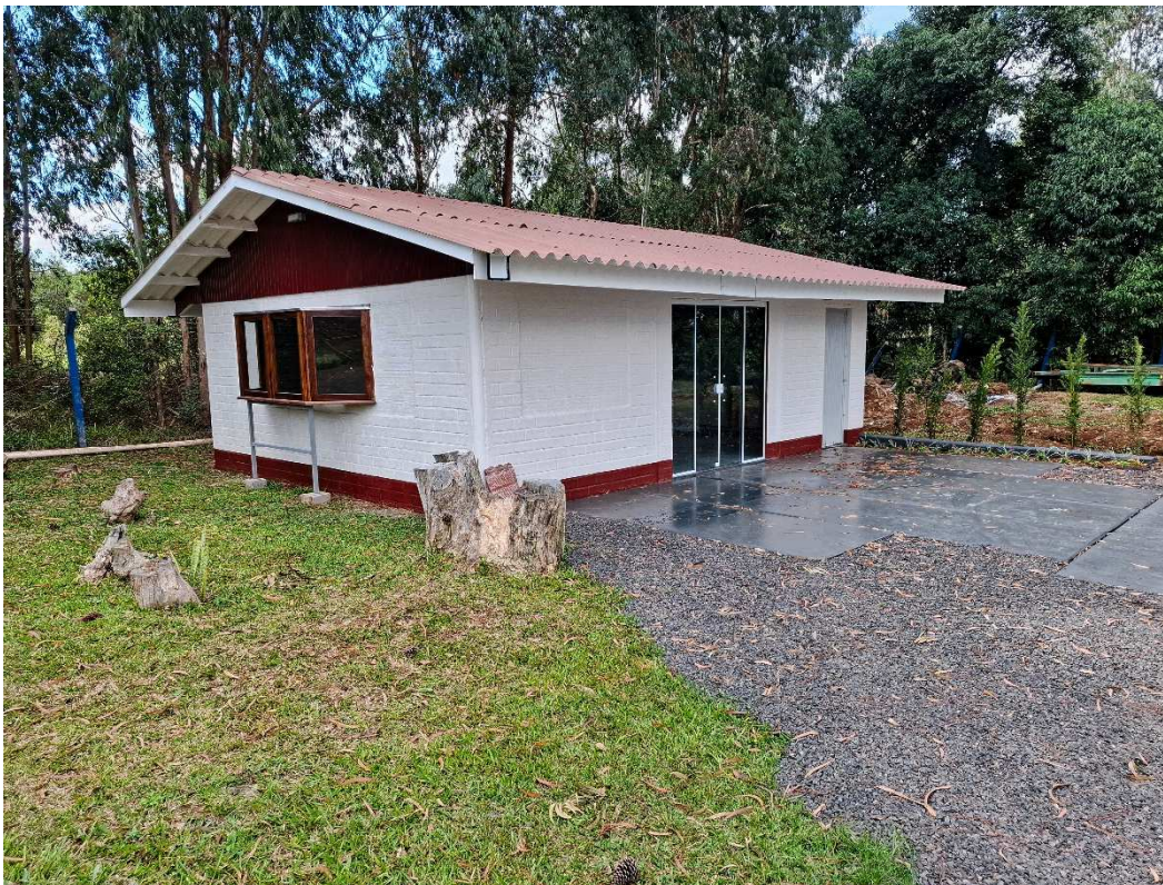
Fotografia 13 – Aspecto externo da Edificação nº 01.
