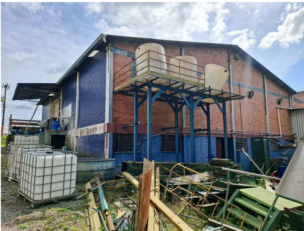
Fotografia 14 – Aspecto externo da Edificação nº 02.
