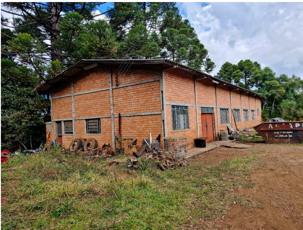
Fotografia 20 – Aspecto externo da Edificação nº 06.
