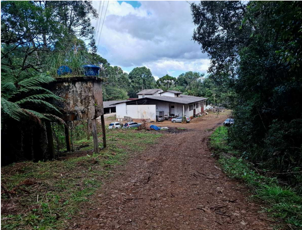
Fotografia 21 – Aspecto interno da Edificação n° 08.
