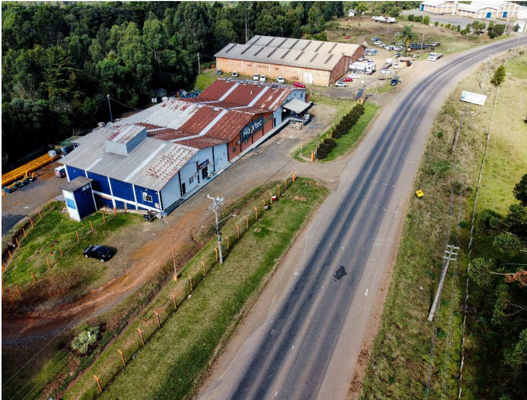
Fotografia 09 – Aspecto geral do imóvel avaliado e das construções existentes.
