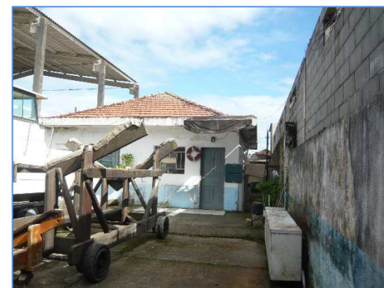
Foto 12 – Vista da edificação do Lote 06
