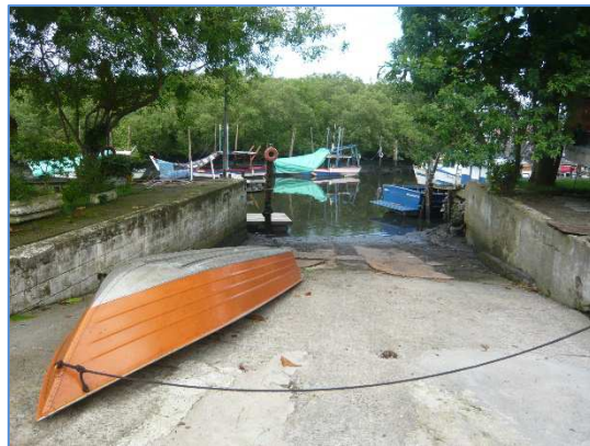
Foto 21 – Vista da rampa náutica
