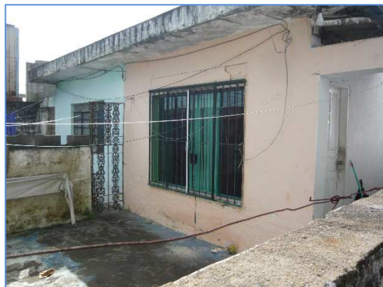
Foto 14 – Vista da edificação do lote 06
