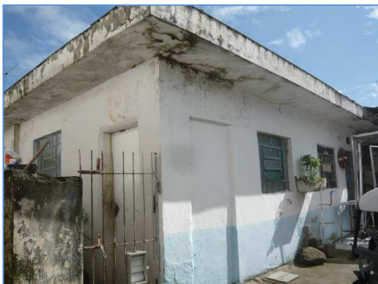
Foto 13 – Vista da edificação do lote 06
