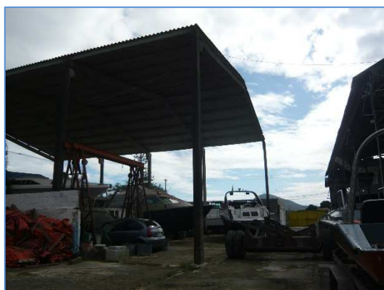
Foto 17 – Vista do galpão 1
