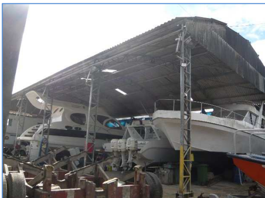
Foto 7 – Vista do galpão 2
