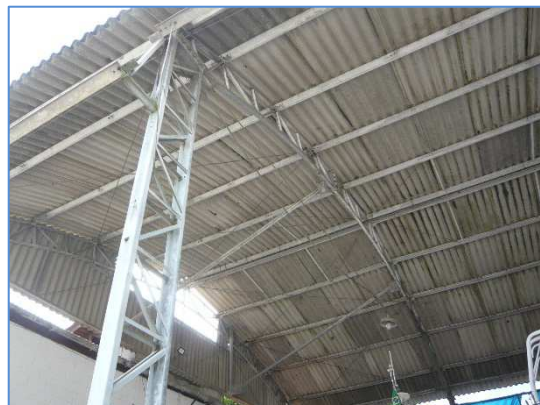
Foto 8 – Vista do galpão 2 de estrutura metálica
