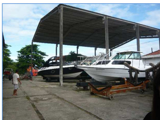
Foto 16 – Vista do galpão 1
