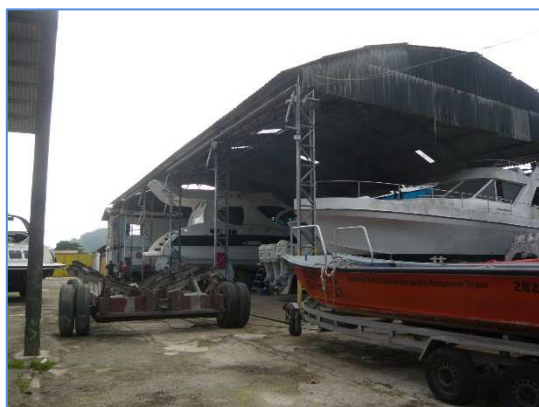
Foto 15 – Vista do Galpão 2
