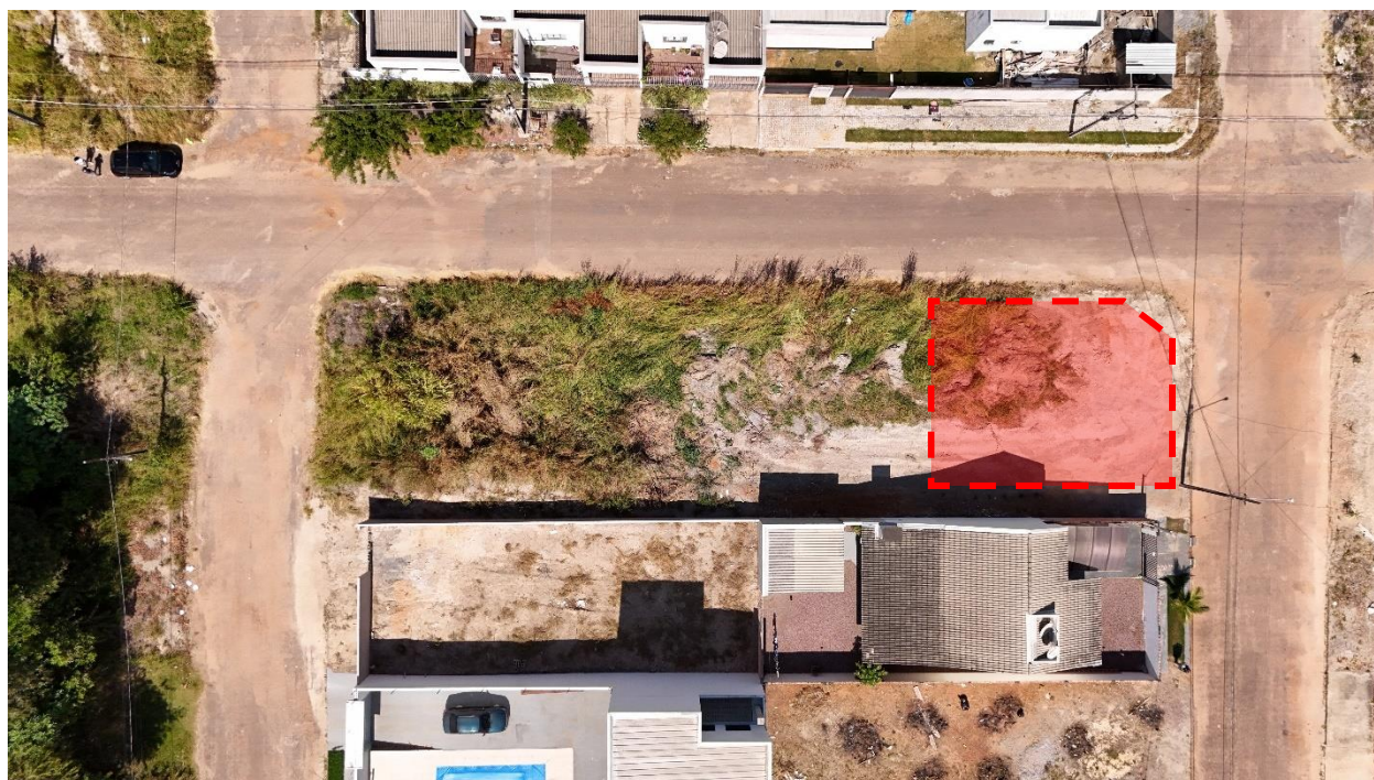
Figura 2: Registro de cima do imóvel avaliado Data: 20/06/2024 Fonte: Autora
