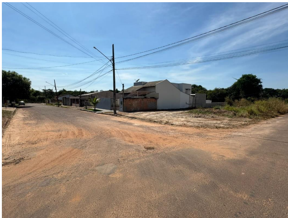
Figura 4: Registro de frente do imóvel avaliado, Rua 5 Data: 20/06/2024 Fonte: Autora
