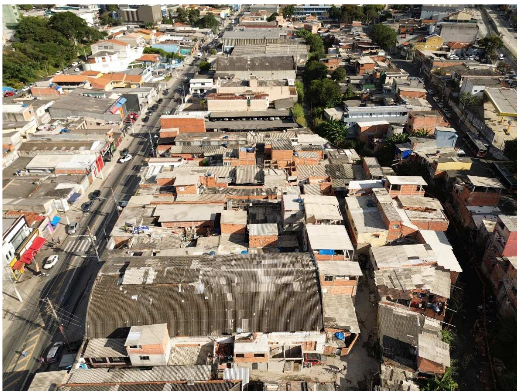
Fotografia 08 – Aspecto geral dos imóveis avaliados, tendo ao lado direito o leito do Rio Verde e ao lado esquerdo a Rua Harry Dannenberg.
