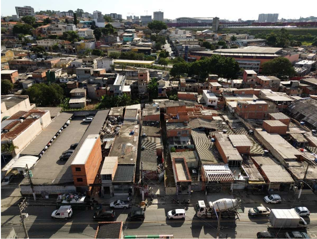
Fotografia 03 – Aspecto geral dos imóveis avaliados e seu entorno imediato.
