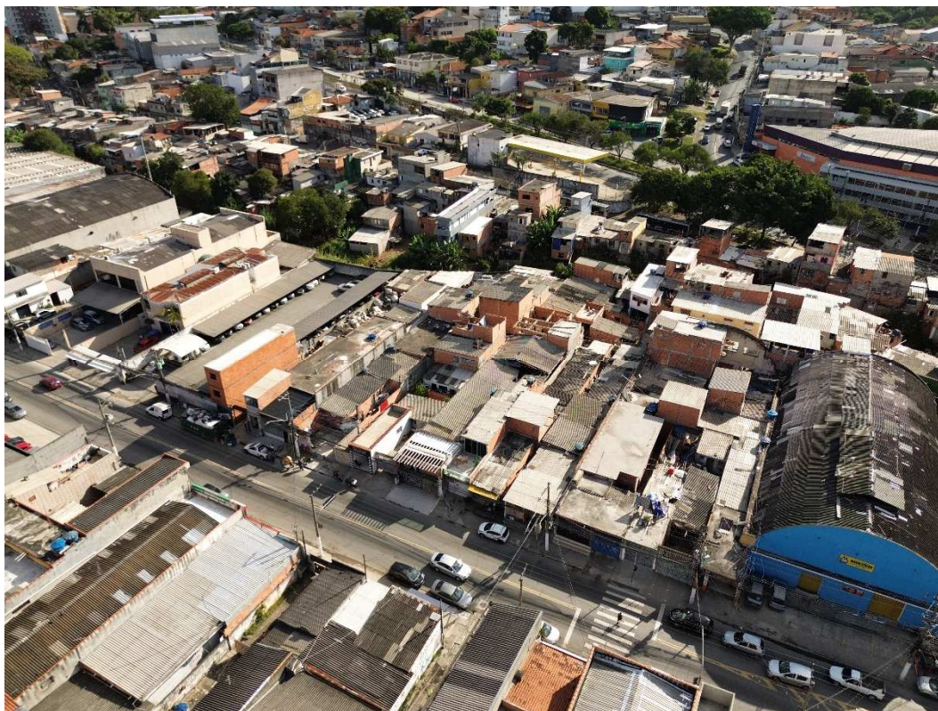
Fotografia 05 – Aspecto geral dos imóveis avaliados e seu entorno imediato.
