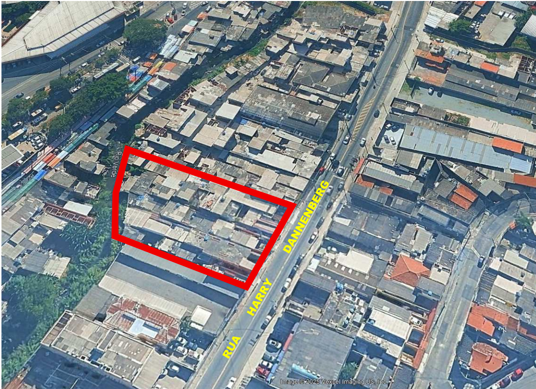
Fotografia 01 – Aspecto dos limites dos imóveis avaliados (em vermelho) e sua via confrontante (Rua Harry Dannenberg).
