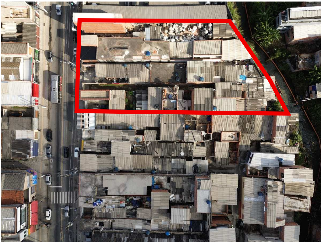
Fotografia 04 – Aspecto geral dos imóveis avaliados (limites em vermelho).
