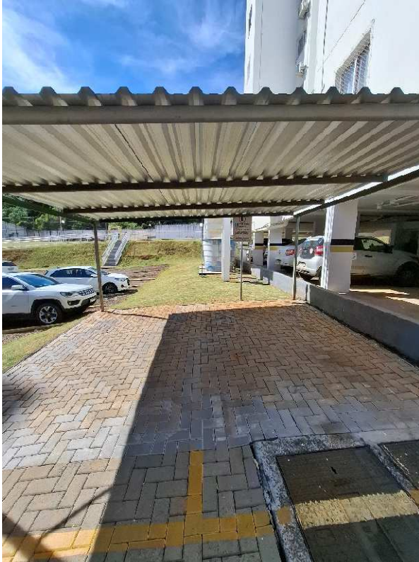
Fotografia 10 – Aspecto da área das vagas de garagem.
