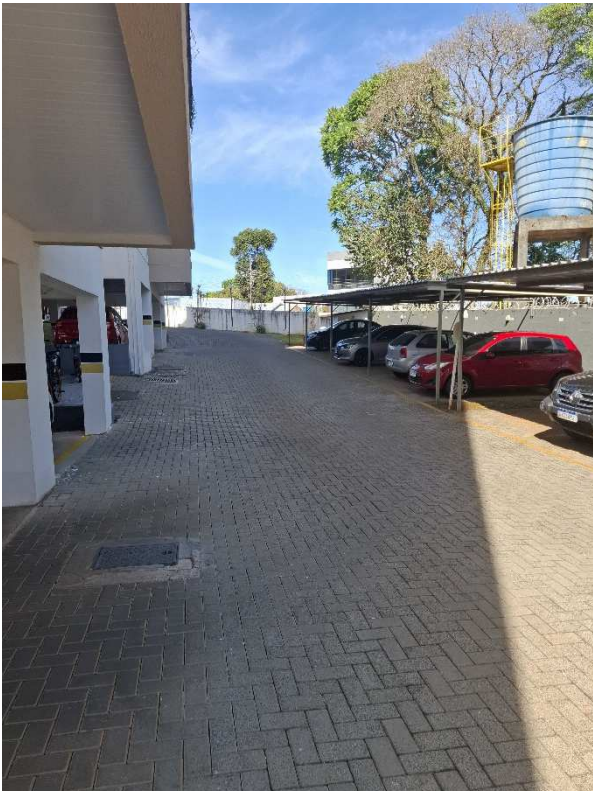
Fotografia 09 – Aspecto da área das vagas de garagem.
