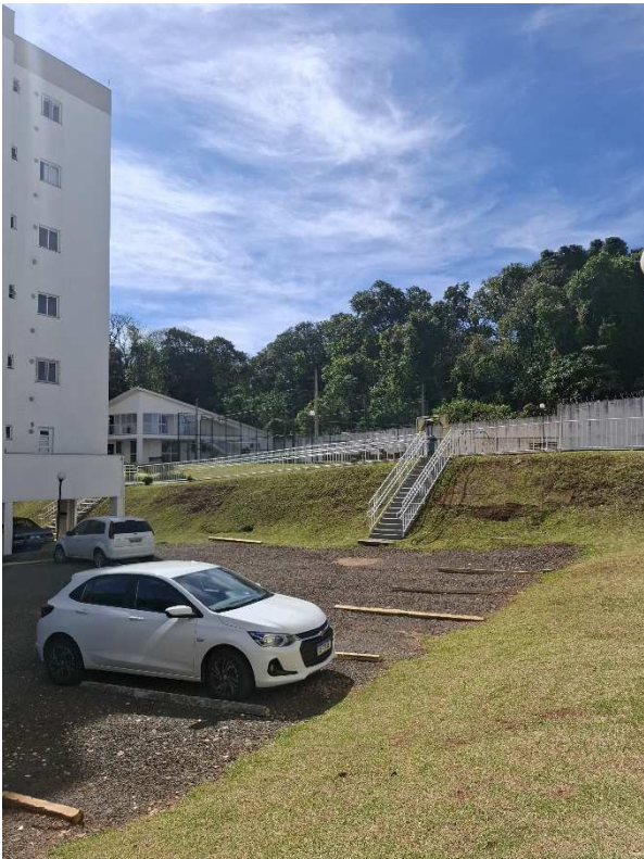
Fotografia 11 – Aspecto da área das vagas de garagem.
