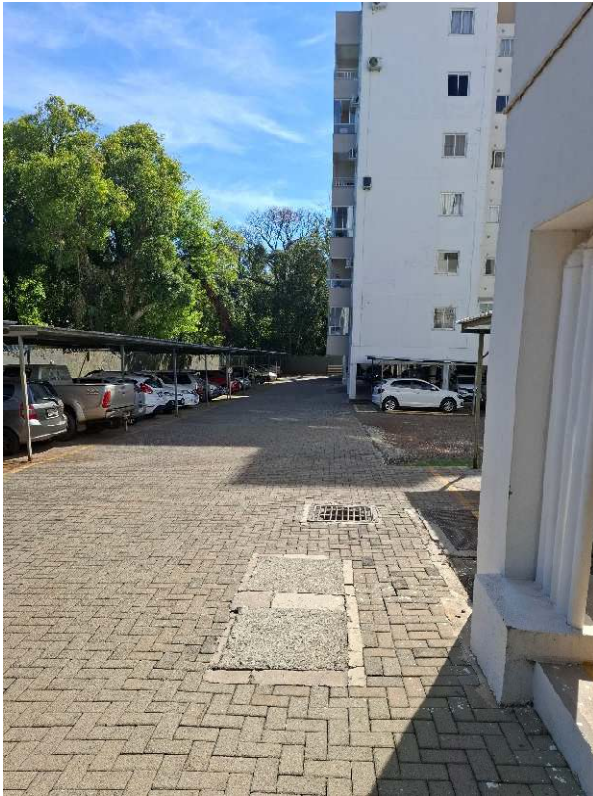
Fotografia 08 – Aspecto da área das vagas de garagem.
