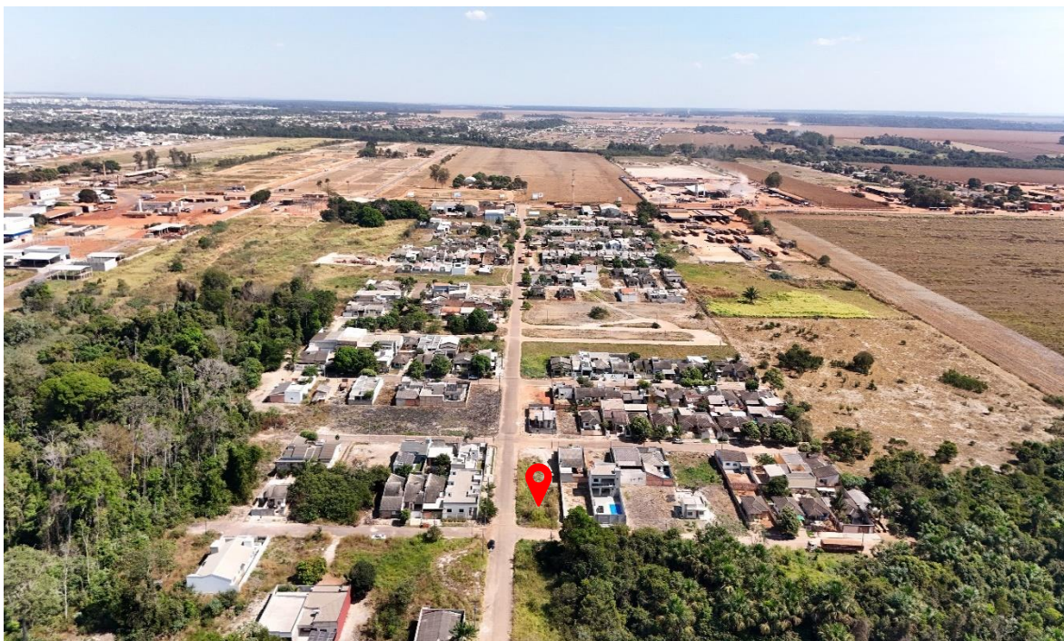
Figura 5: Registro de cima do imóvel avaliado, Rua Antônio Padovani com vista para BR163 Data: 20/06/2024 Fonte: Autora
