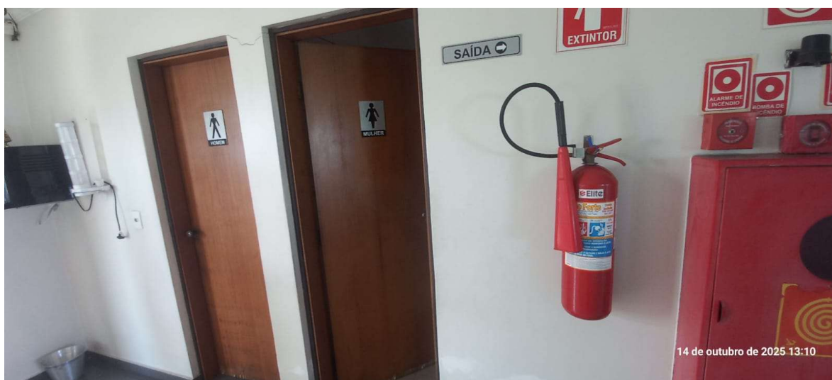
Lavabo área adm-Prédio comercial
