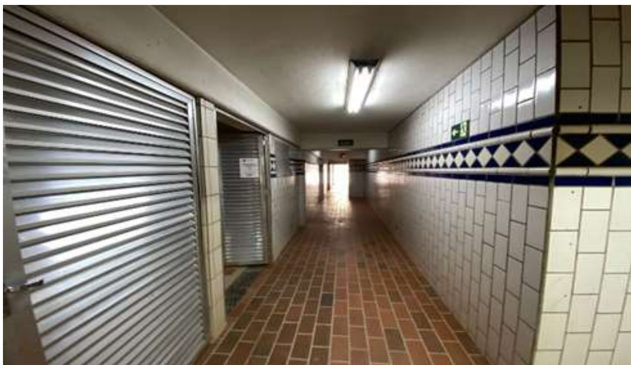
Figura 50 - Acesso às áreas administrativas
