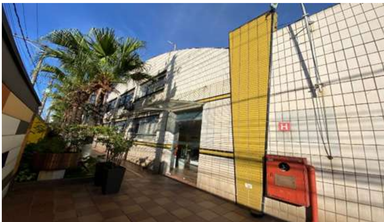
Figura 14 - Acesso ao imóvel
