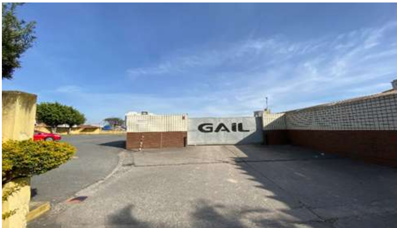
Figura 09 - Acesso ao imóvel
