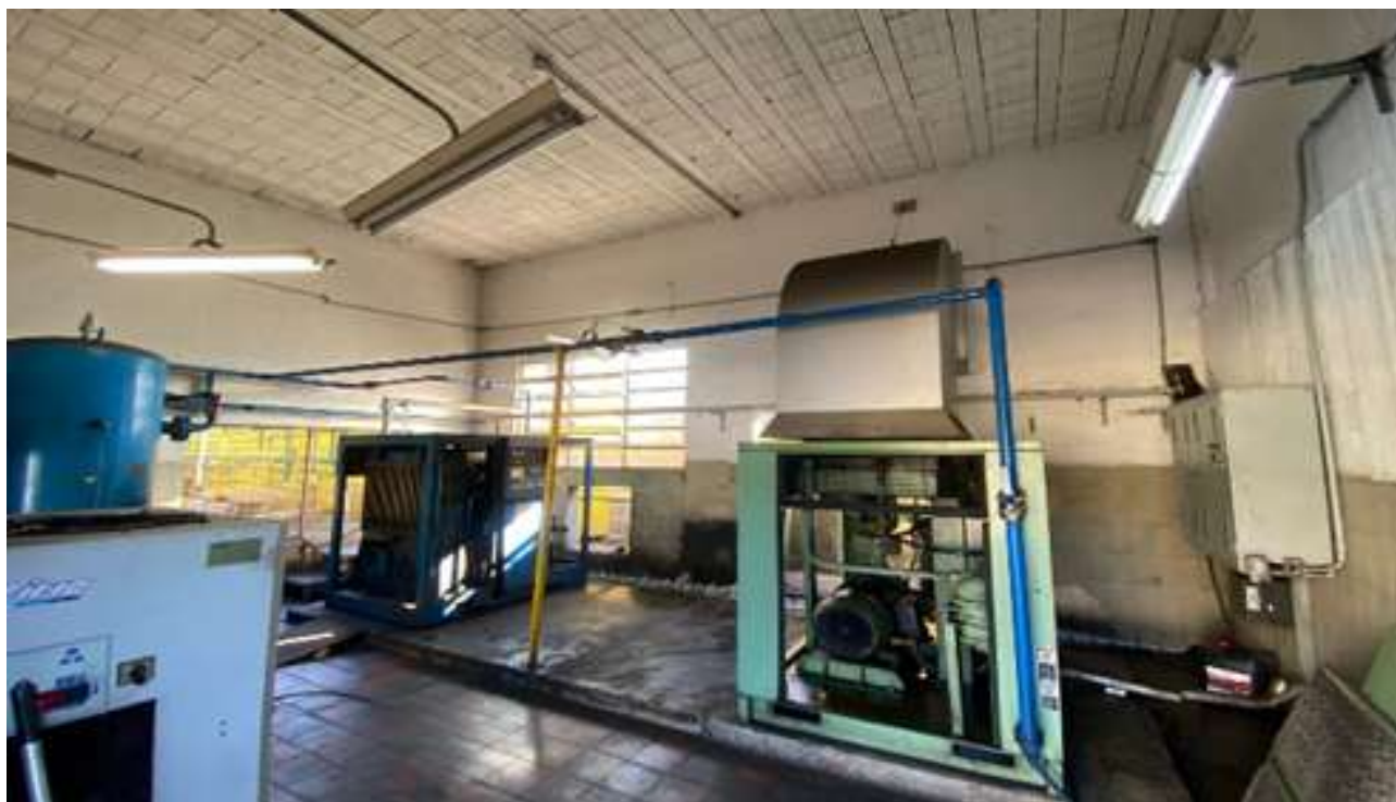
Figura 17 - Prédios de apoio
