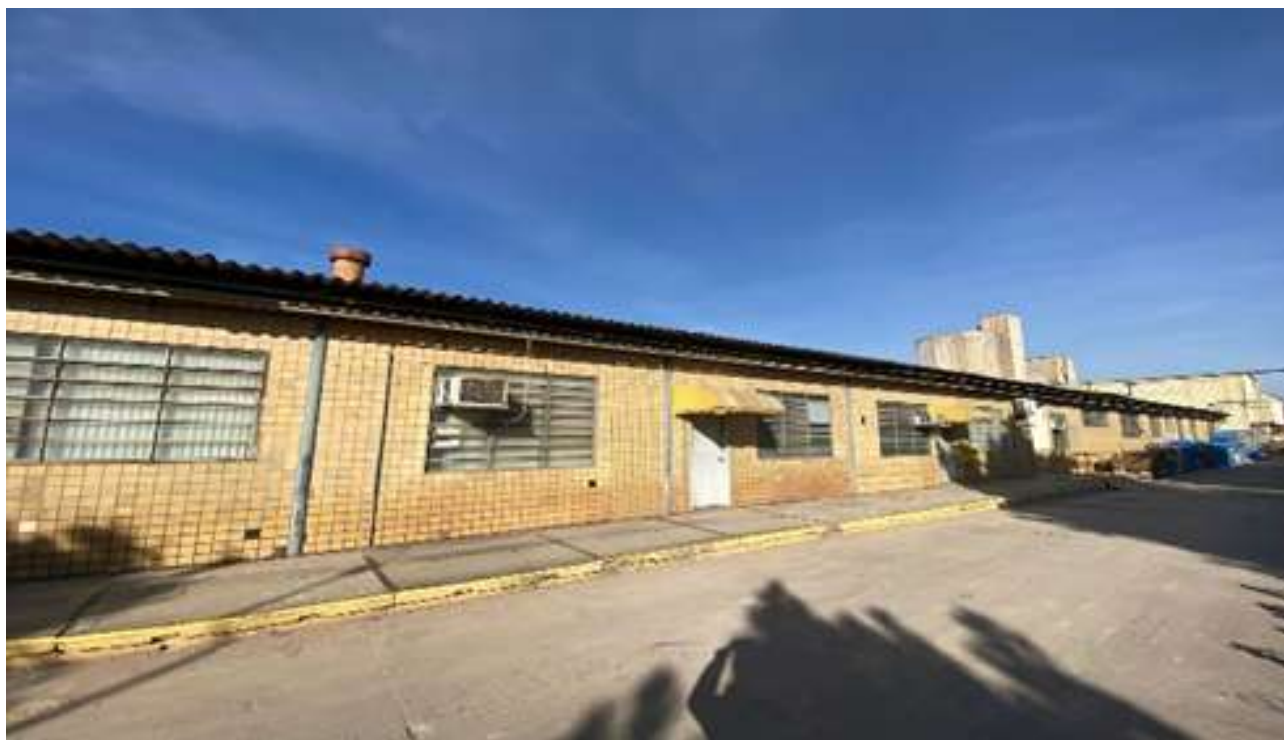
Figura 18 - Prédios de apoio
