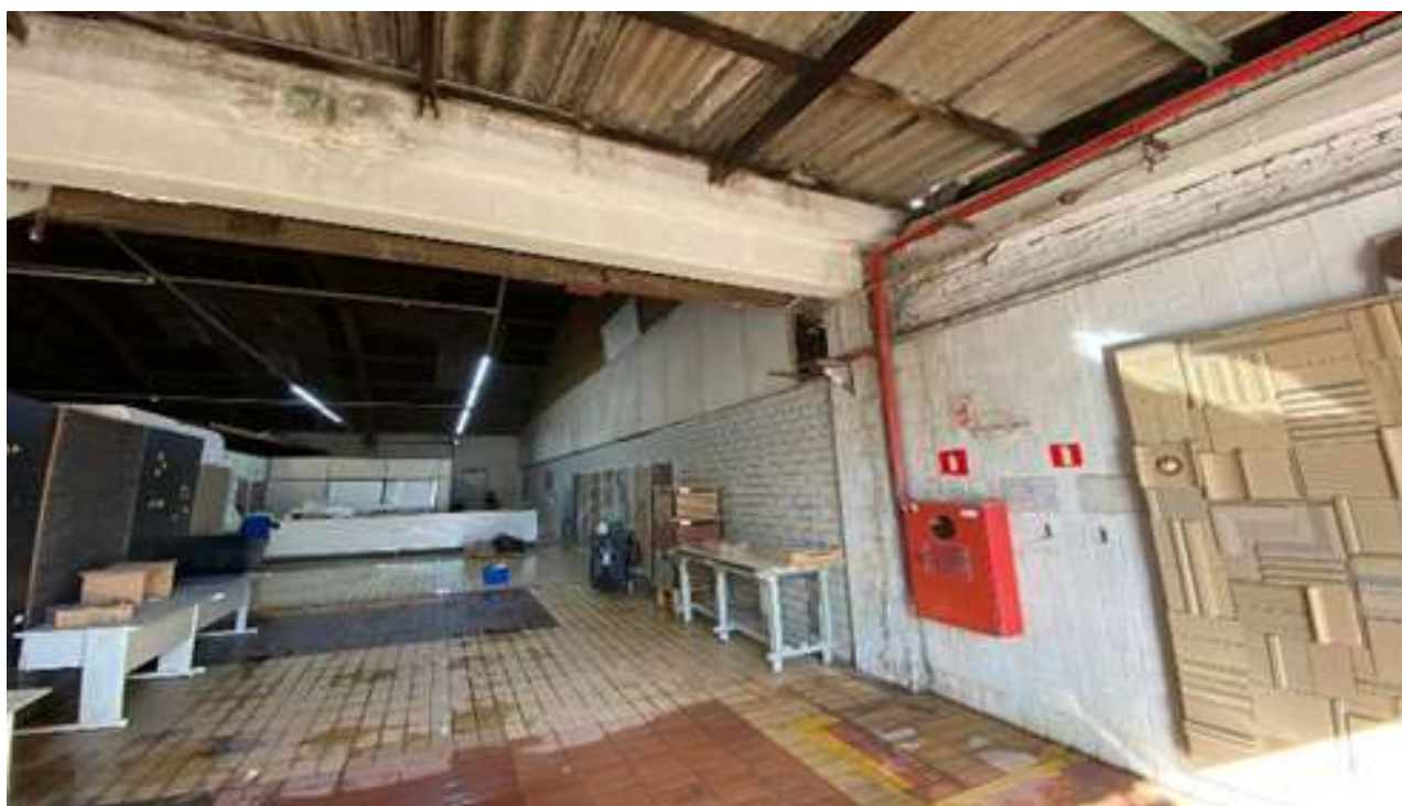
Figura 65 - Acesso ao galpão
