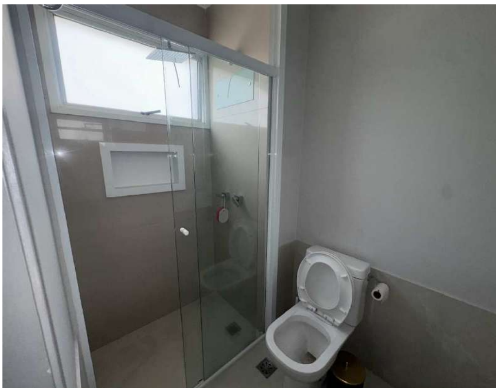
Fotografia 16 – Aspecto interno da Unidade nº 171 do Condomínio Soho Campinas.
