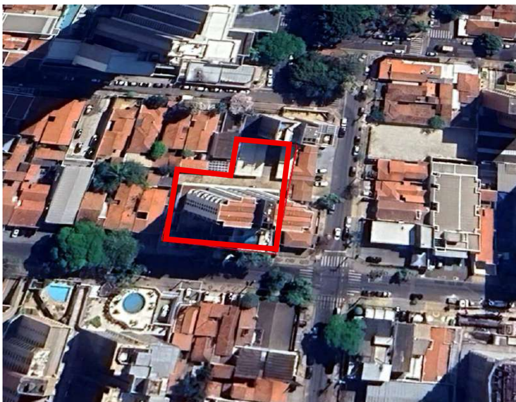
Fotografia 02 –Aspecto geral do Condomínio Duets Loft (em vermelho).
