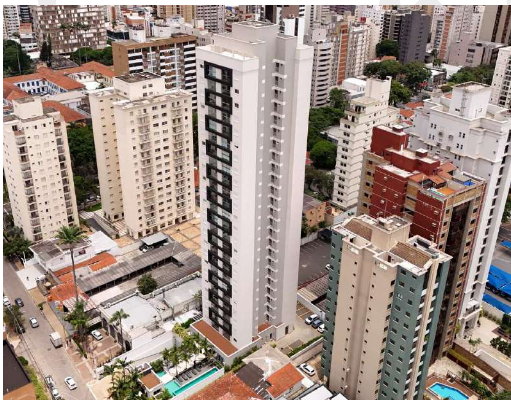
Fotografia 04 – Aspecto geral do Condomínio Unic.
