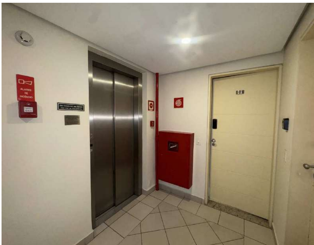
Fotografia 20 – Aspecto do hall de elevador na área comum interna.
