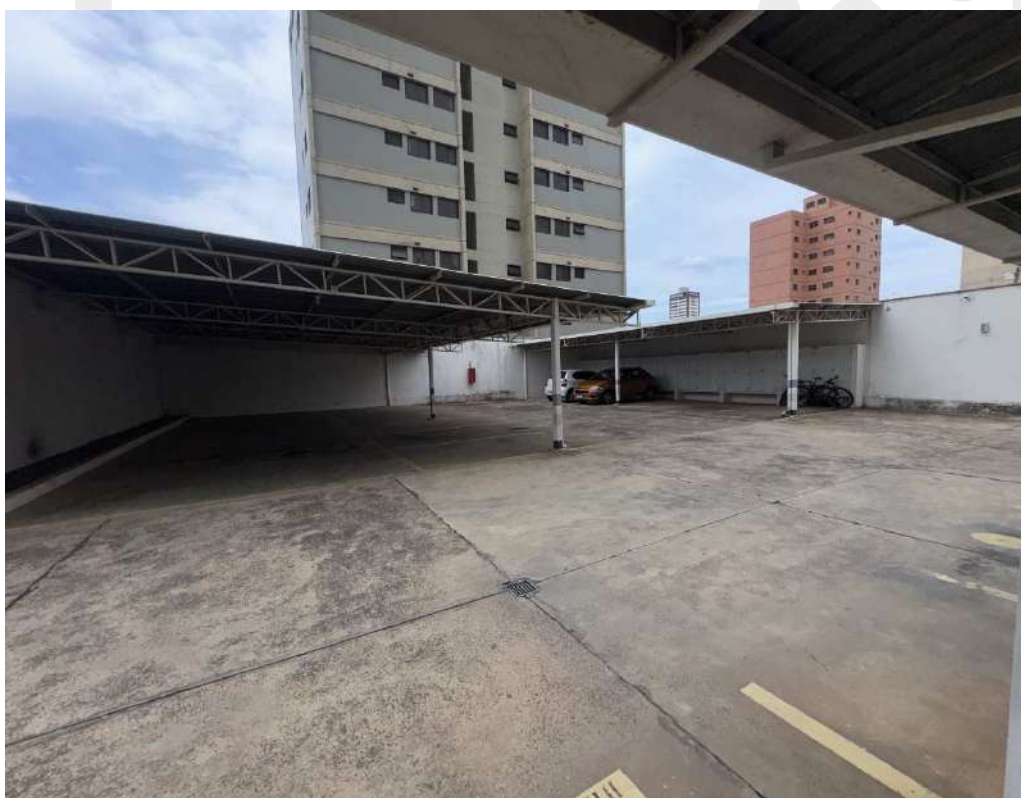
Fotografia 09 – Aspecto da área comum externa do Condomínio Duets Loft.
