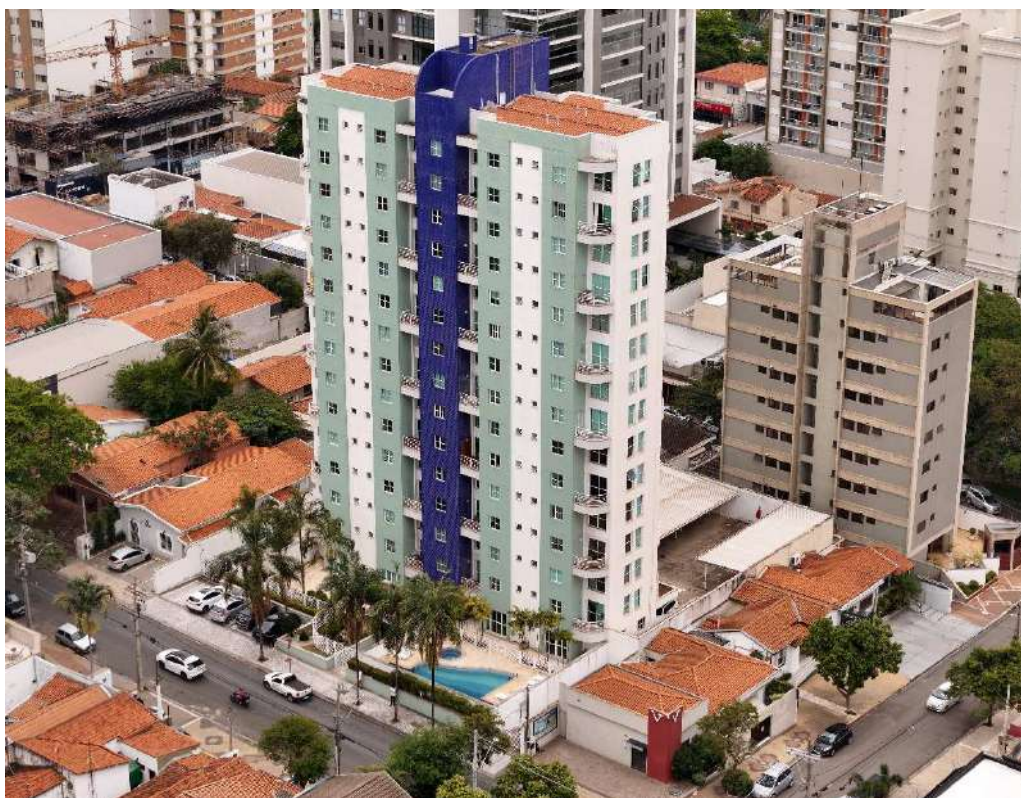
Fotografia 04 – Aspecto geral do Condomínio Duets Loft.
