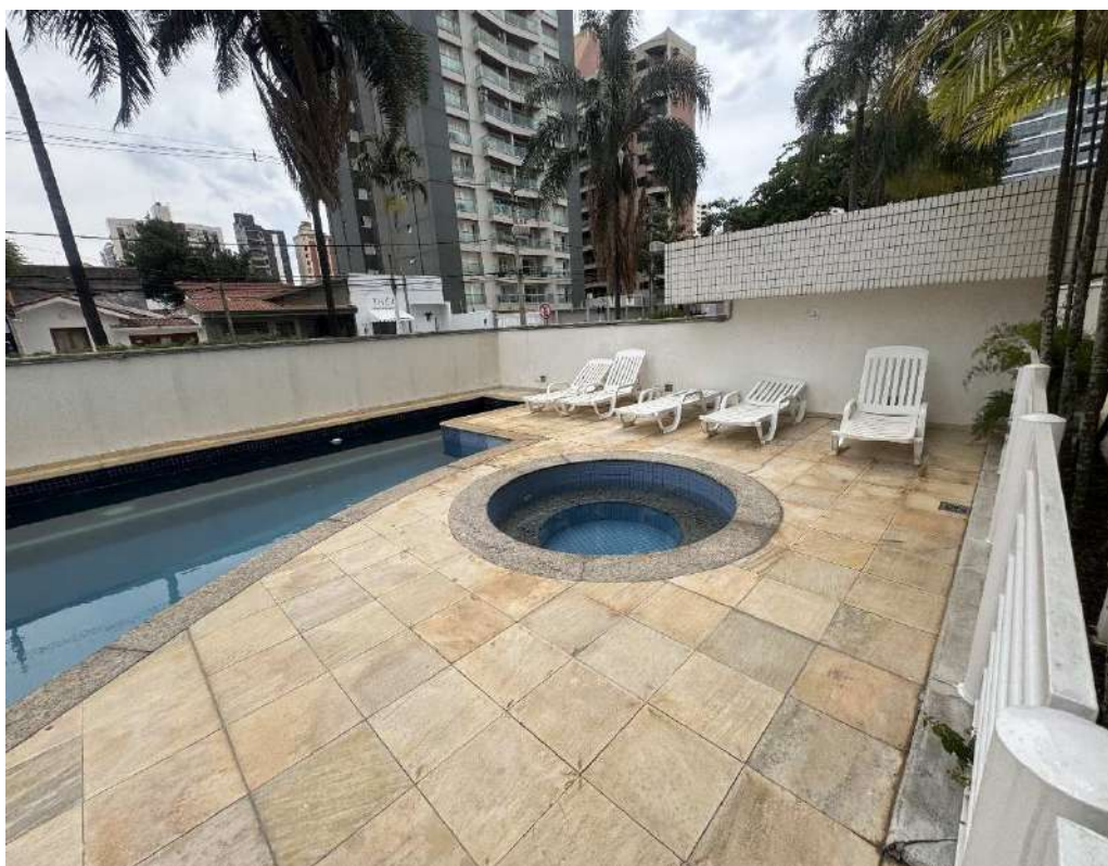
Fotografia 06 – Aspecto da área comum externa do Condomínio Duets Loft.
