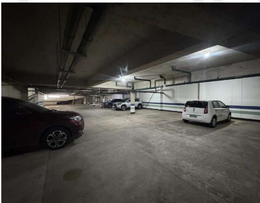
Fotografia 11 – Aspecto do subsolo (garagem) do Condomínio Duets Loft.
