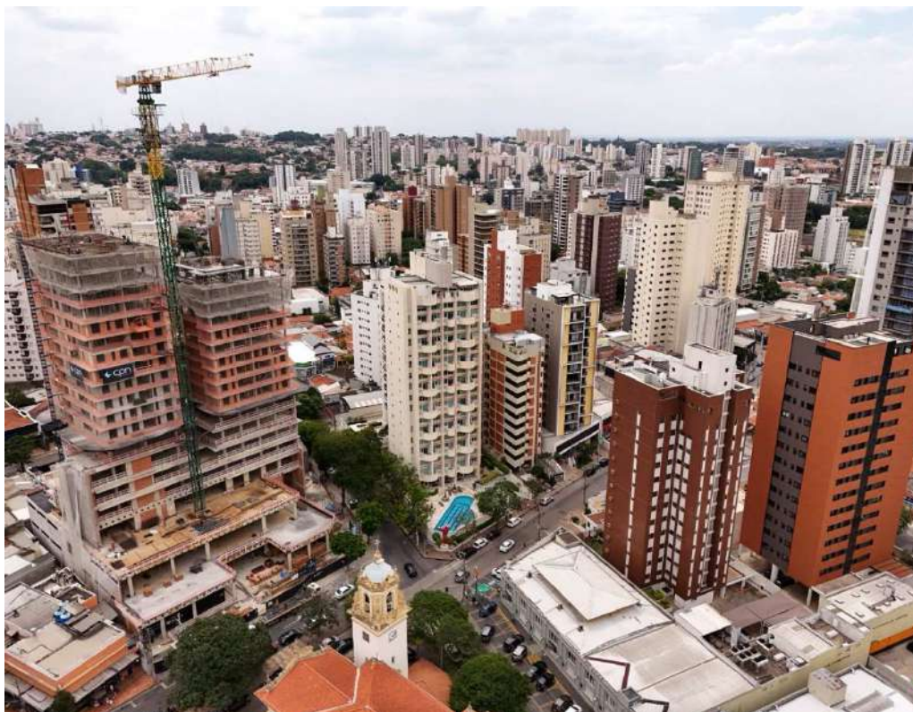
Fotografia 06 – Aspecto geral do Condomínio Soho Campinas e seu entorno.
