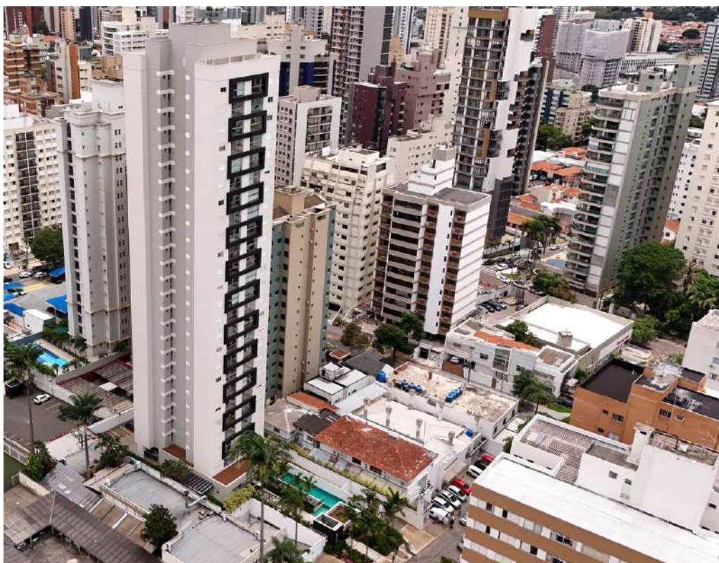
Fotografia 03 – Aspecto geral do Condomínio Unic junto à Rua Benjamin Constant.
