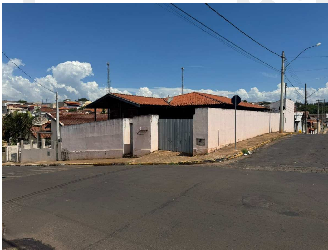
Fotografia 08 – Aspecto geral externo do imóvel avaliado juntos ao alinhamento da Rua Professor José de Oliveira e Rua Nove de Julho.
