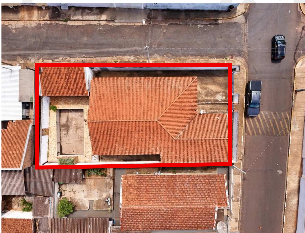
Fotografia 02 – Aspecto do perímetro do imóvel avaliado ( em vermelho ) junto aos alinhamentos da Rua Professor José de Oliveira e Rua Nove de Julho.
