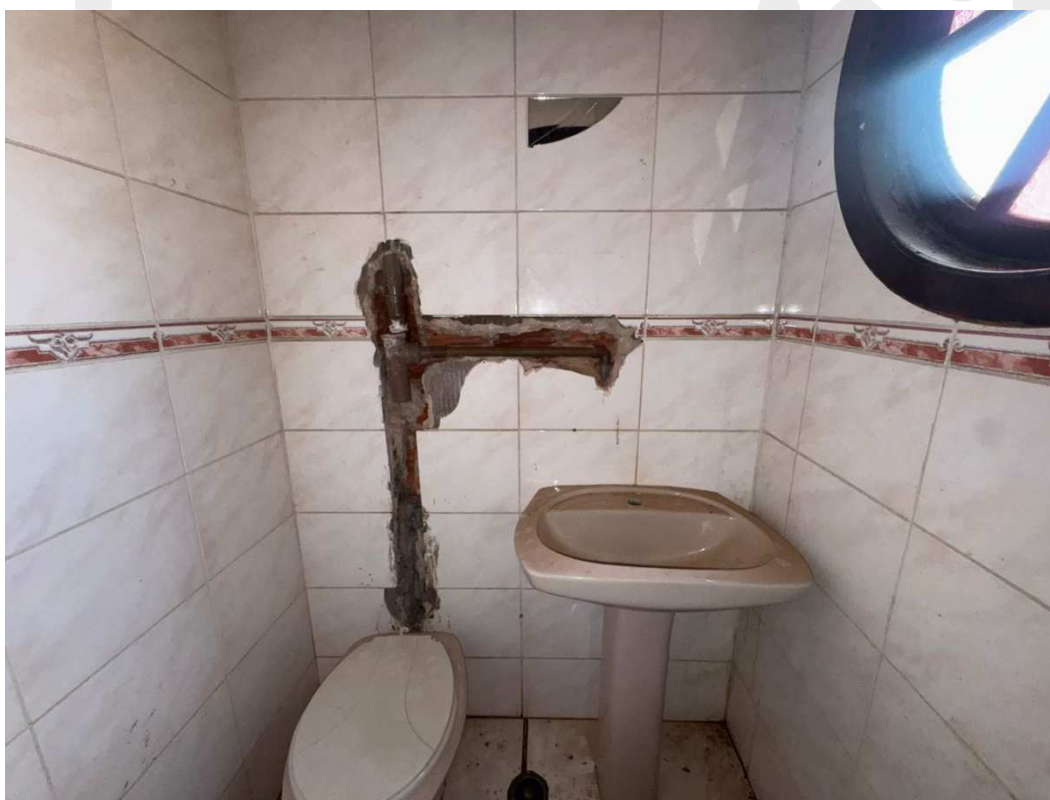
Fotografia 16 – Aspecto interno do imóvel avaliado.
