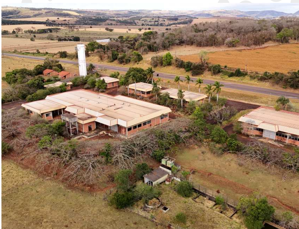
Fotografia 07 – Aspecto das construções existentes no imóvel avaliado.
