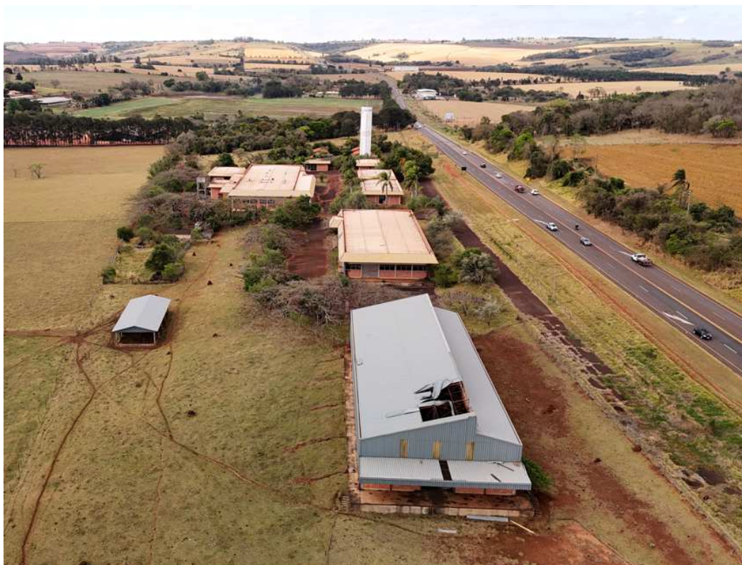
Fotografia 08 – Aspecto das construções existentes no imóvel avaliado.
