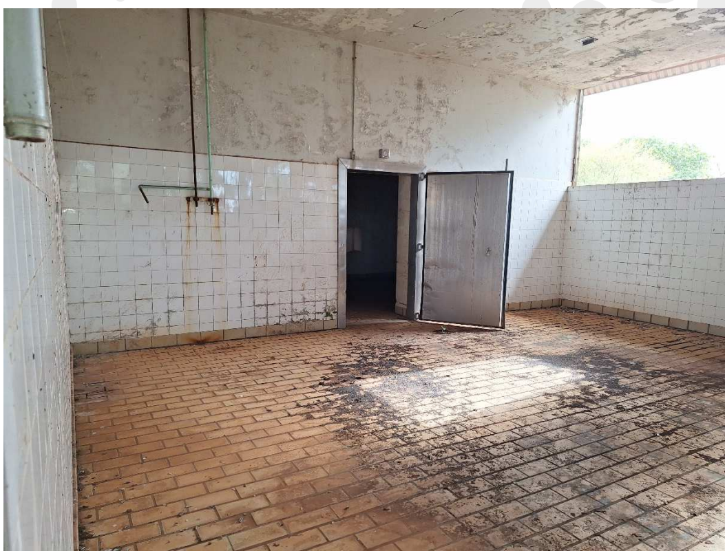
Fotografia 23 – Aspecto interno das construções existentes.
