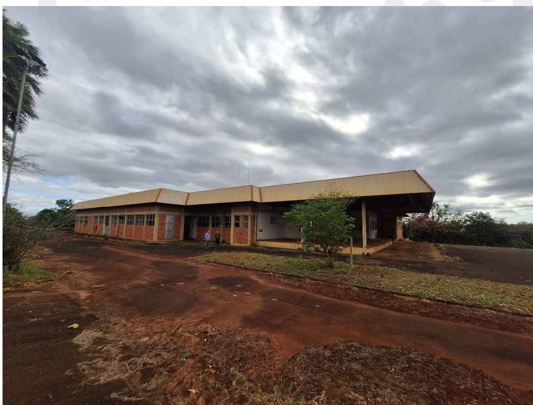
Fotografia 17 – Aspecto externo das construções existentes.
