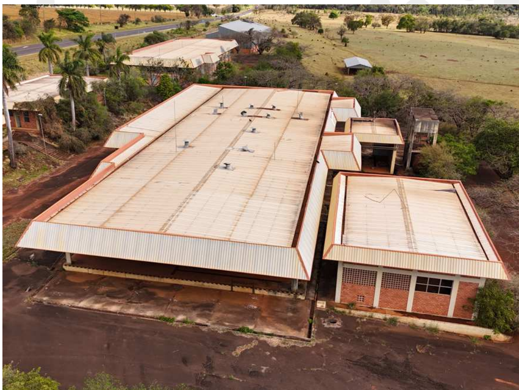
Fotografia 09 – Aspecto das construções existentes no imóvel avaliado.
