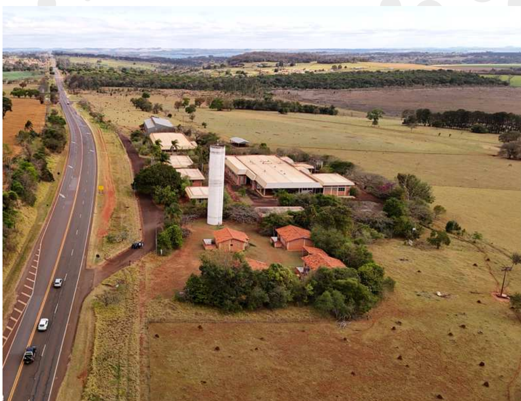
Fotografia 05 – Aspecto geral do imóvel avaliado.
