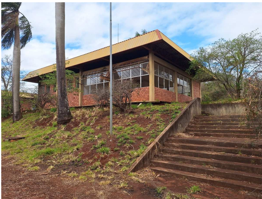
Fotografia 16 – Aspecto externo das construções existentes.
