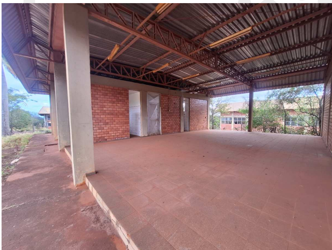
Fotografia 25 – Aspecto interno das construções existentes.
