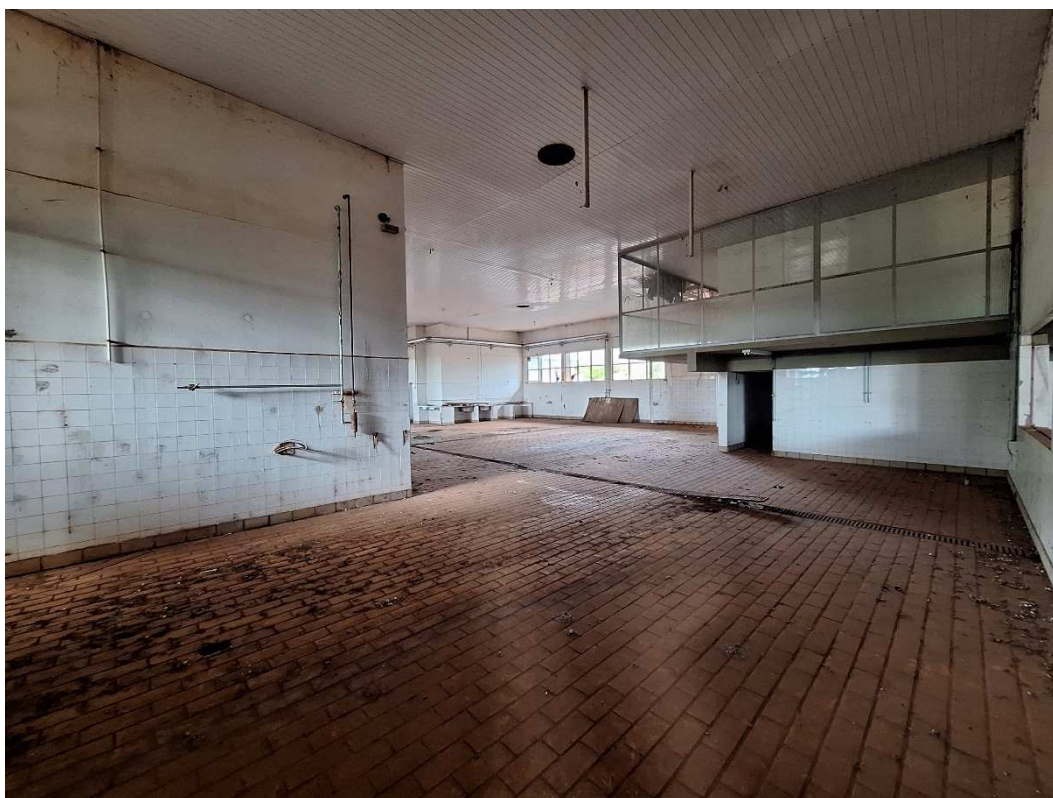
Fotografia 22 – Aspecto interno das construções existentes.
