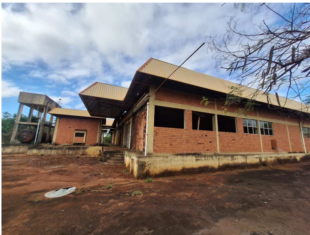
Fotografia 14 – Aspecto externo das construções existentes.
