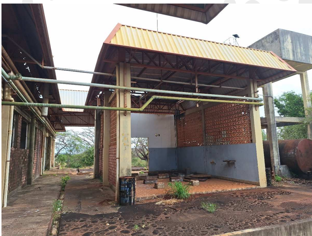
Fotografia 13 – Aspecto externo das construções existentes.
