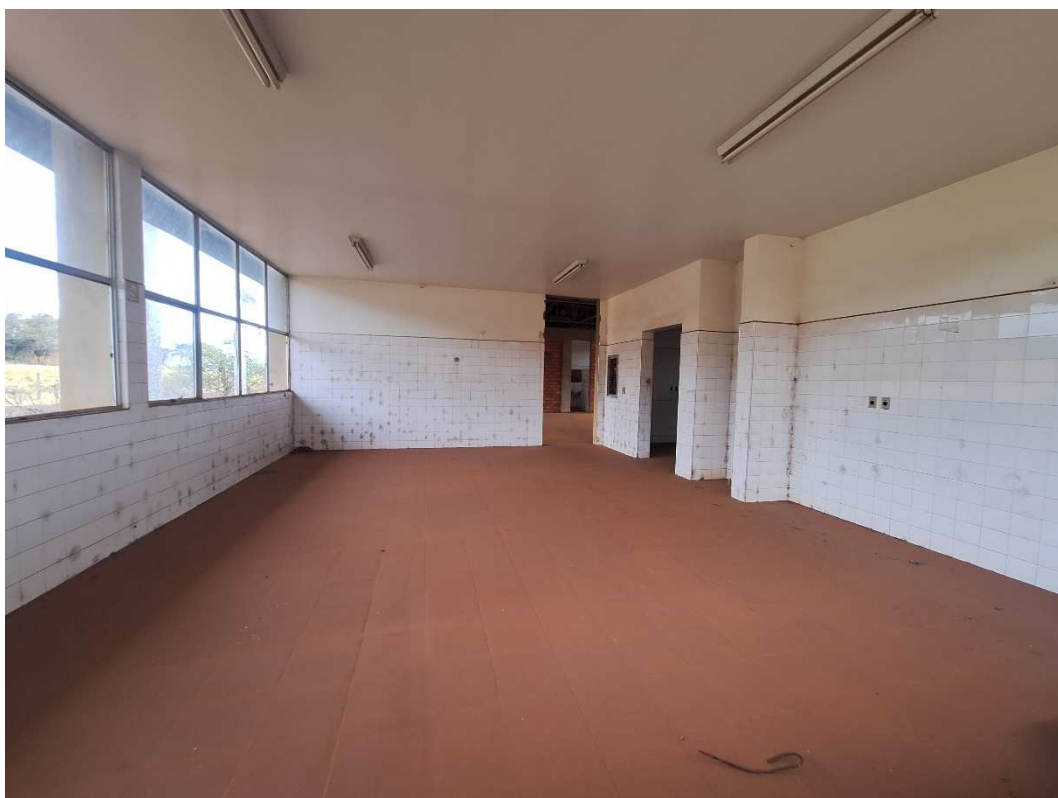
Fotografia 24 – Aspecto interno das construções existentes.
