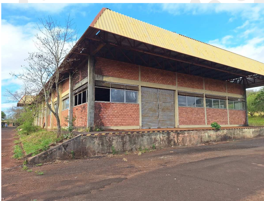
Fotografia 19 – Aspecto externo das construções existentes.
