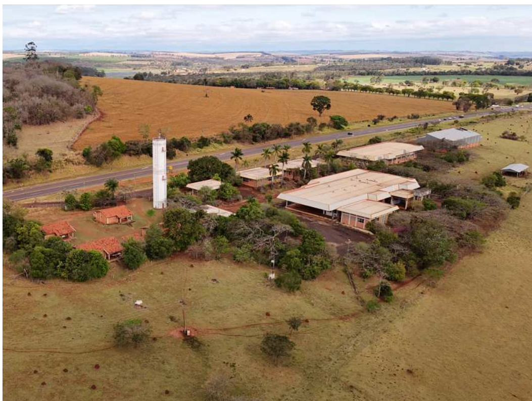
Fotografia 06 – Aspecto das construções existentes no imóvel avaliado.
