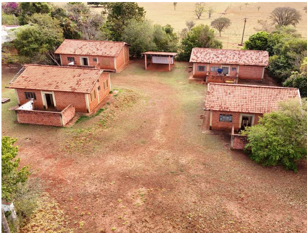
Fotografia 10 – Aspecto das construções existentes no imóvel avaliado.
