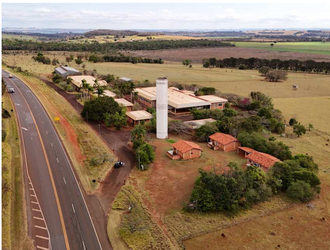
Fotografia 04 – Aspecto geral do imóvel avaliado.
