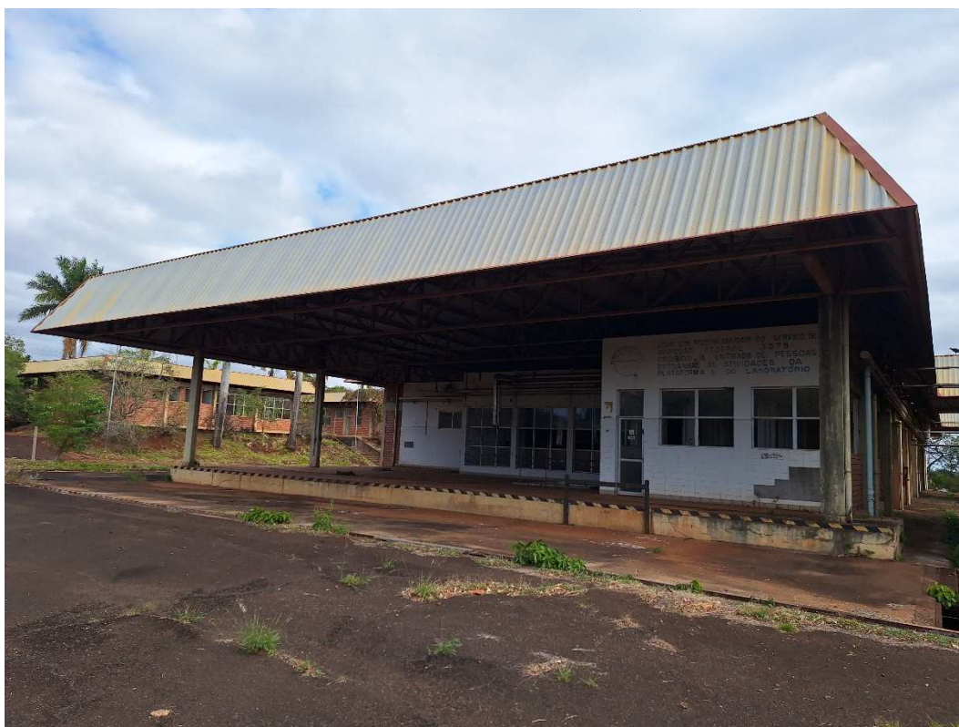
Fotografia 12 – Aspecto externo das construções existentes.
