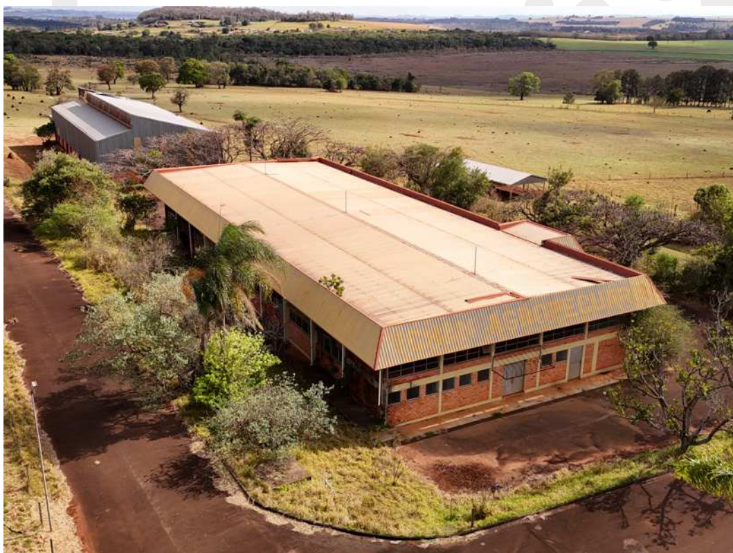
Fotografia 11 – Aspecto das construções existentes no imóvel avaliado.
