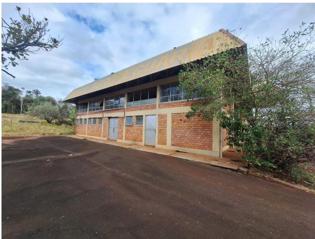
Fotografia 18 – Aspecto externo das construções existentes.
