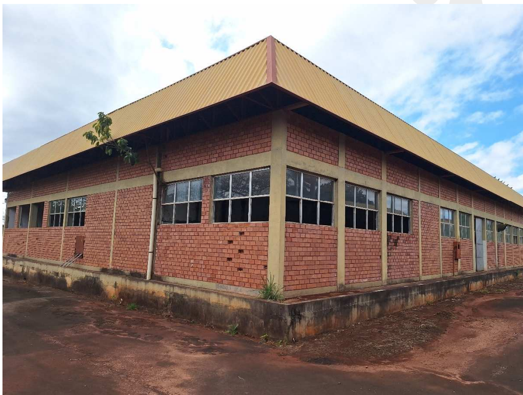
Fotografia 15 – Aspecto externo das construções existentes.
