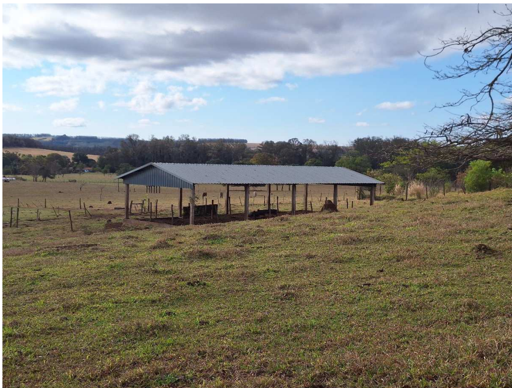
Fotografia 20 – Aspecto externo das construções existentes.
