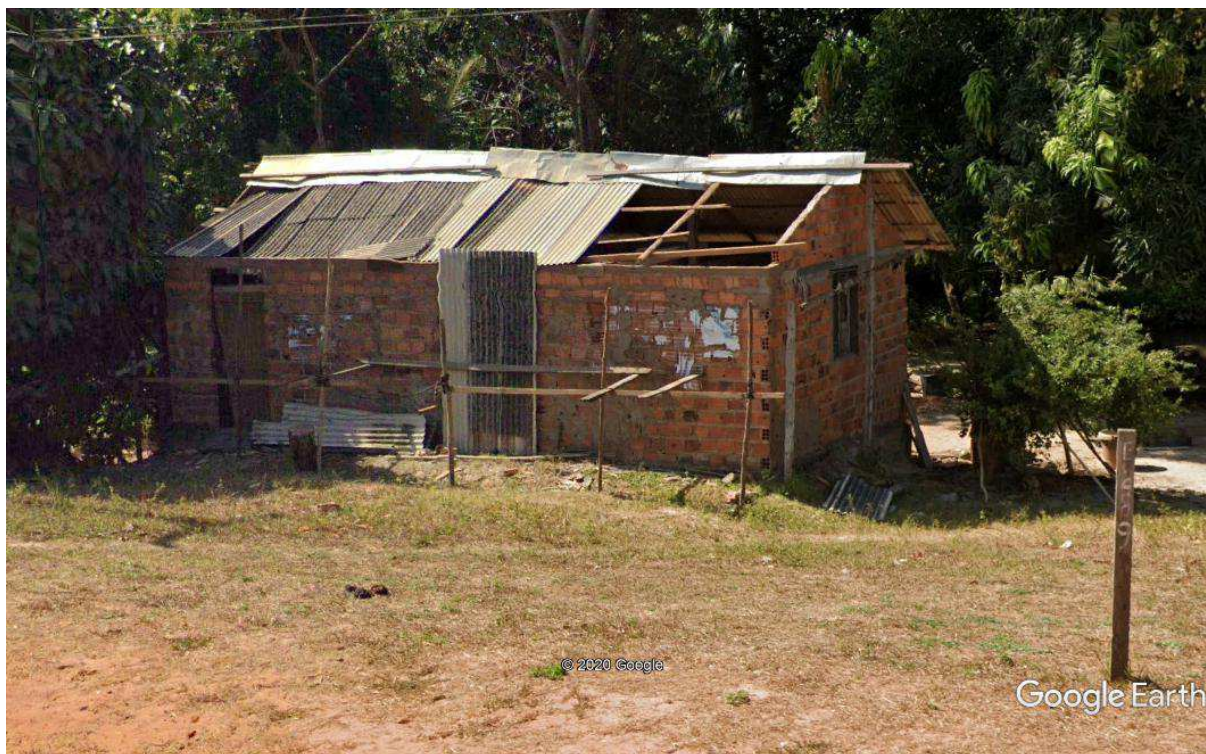
Foto 16 – Vista da construção existente no interior do imóvel avaliando
