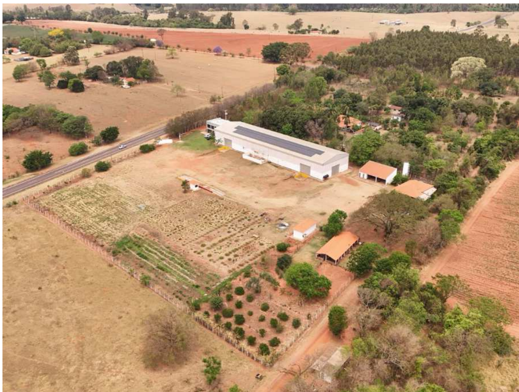
Fotografia 07 – Aspecto geral do imóvel avaliado.
