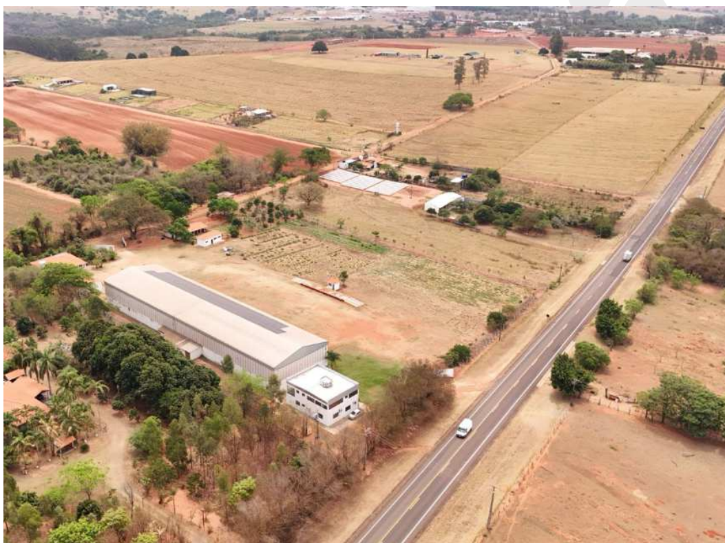
Fotografia 06 – Aspecto geral do imóvel avaliado.
