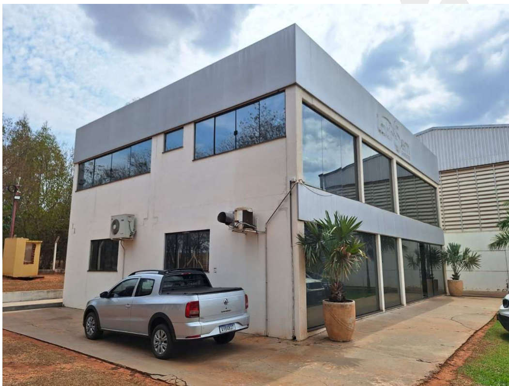
Fotografia 08 – Aspecto das edificações existentes (Escritório).
