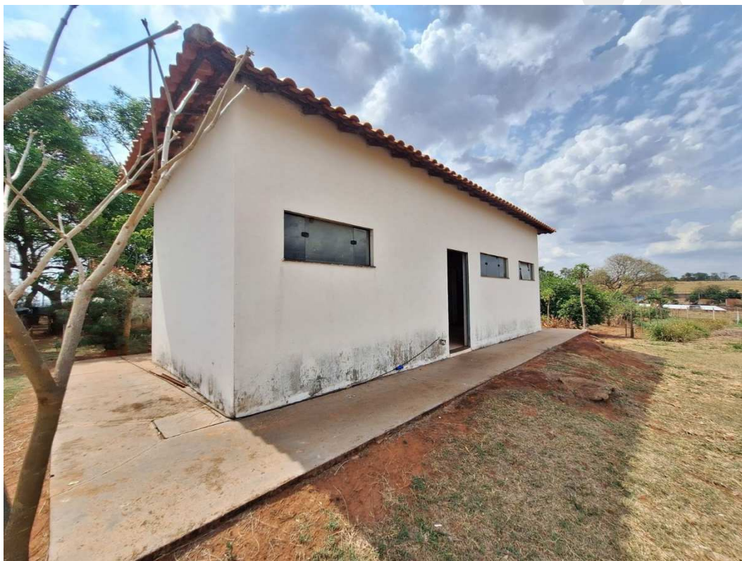
Fotografia 24 – Aspecto externo do Vestiário.
