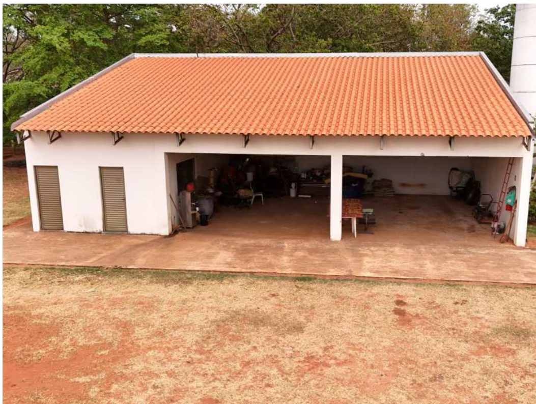
Fotografia 27 – Aspecto externo do Depósito 01.
