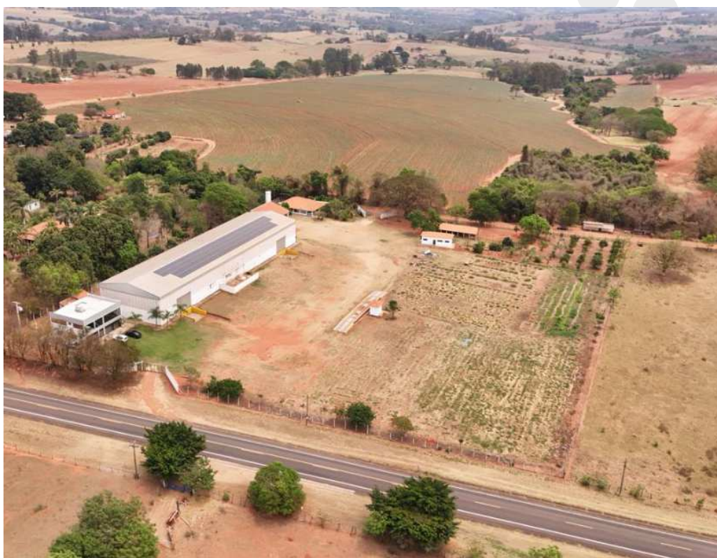
Fotografia 04 – Aspecto geral do imóvel avaliado.
