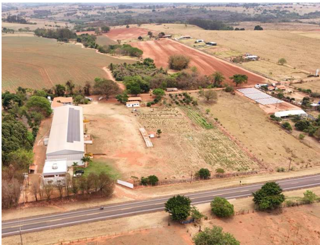
Fotografia 05 – Aspecto geral do imóvel avaliado.
