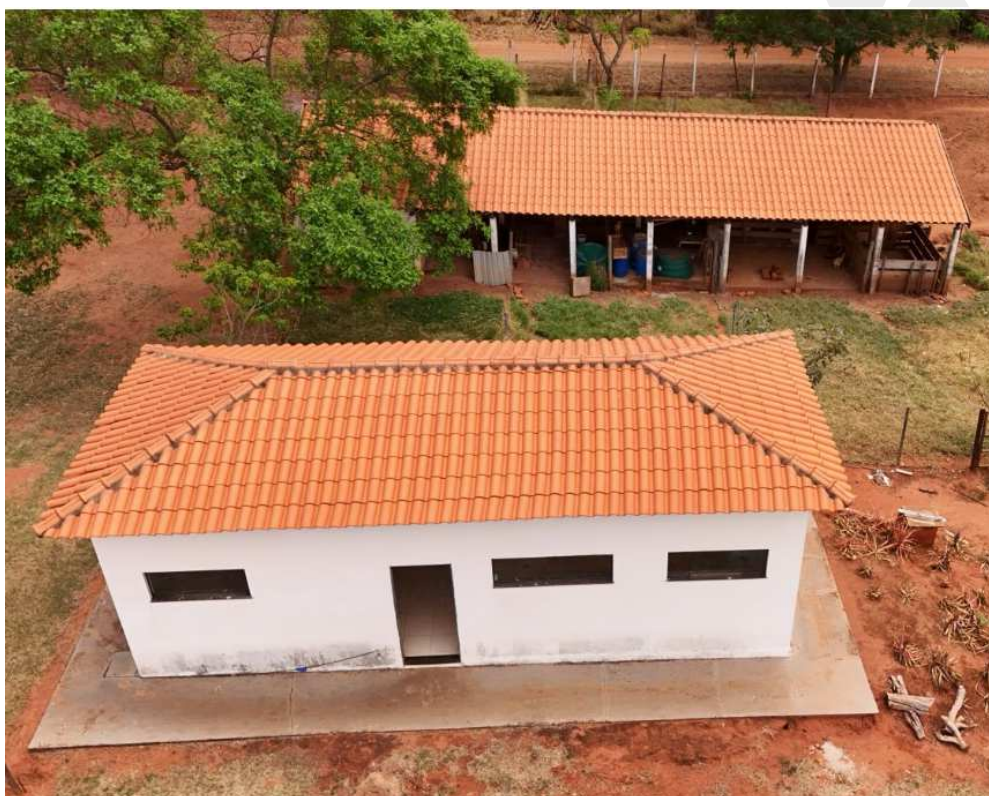
Fotografia 26 – Aspecto externo do Vestiário e Depósito 2.
