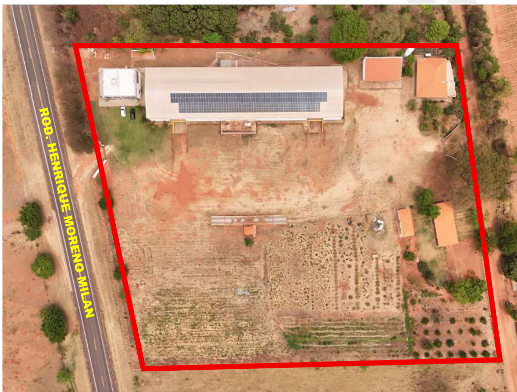
Fotografia 02 – Aspecto dos limites do imóvel avaliado (em vermelho) em relação à Rodovia SPA 553/270 – Rodovia Henrique Moreno Milan.
