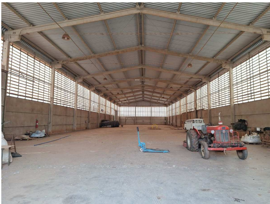
Fotografia 19 – Aspecto interno do Galpão.
