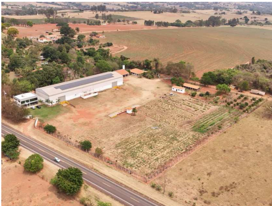
Fotografia 03 – Aspecto geral do imóvel avaliado.
