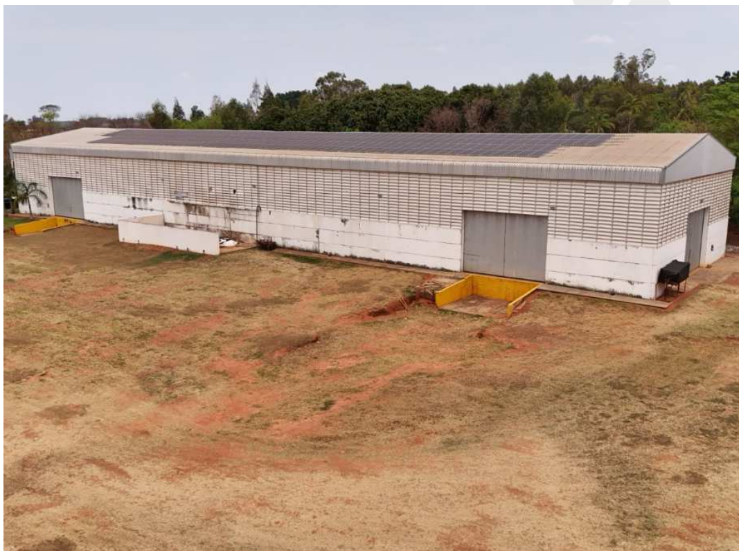
Fotografia 18 – Aspecto externo do Galpão.
