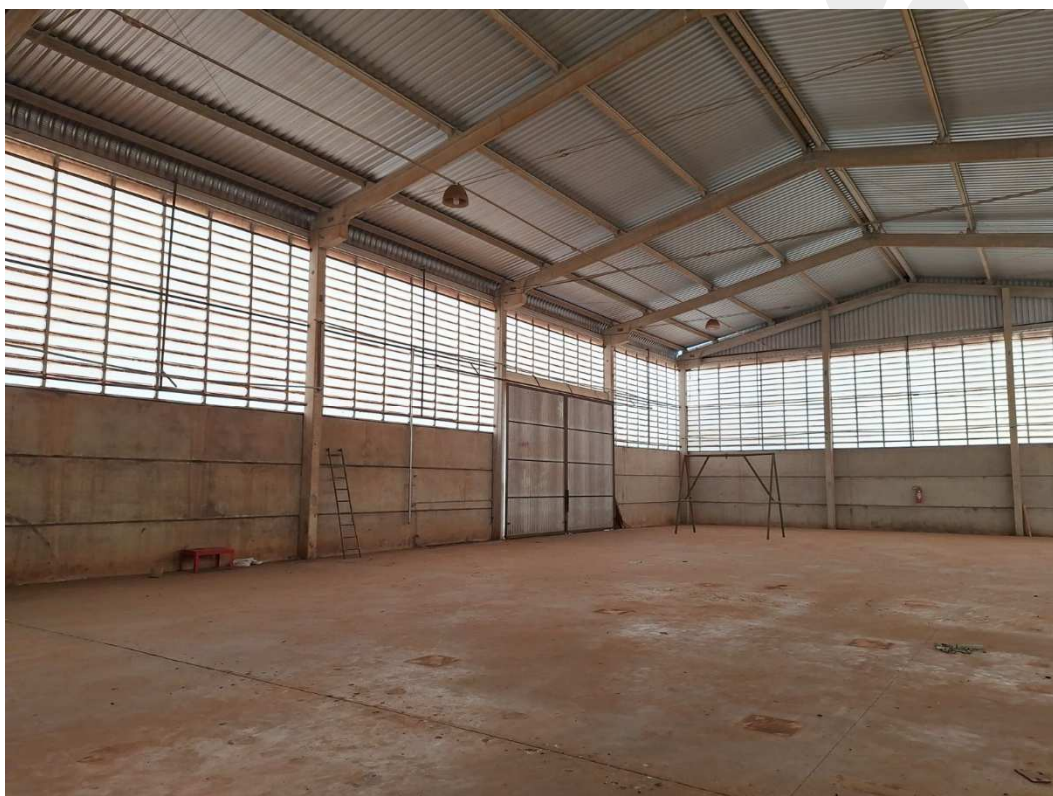
Fotografia 20 – Aspecto interno do Galpão.
