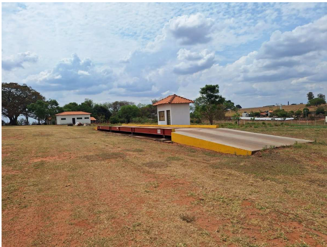
Fotografia 17 – Aspecto externo da edificação que abriga a Casa da Balança.
