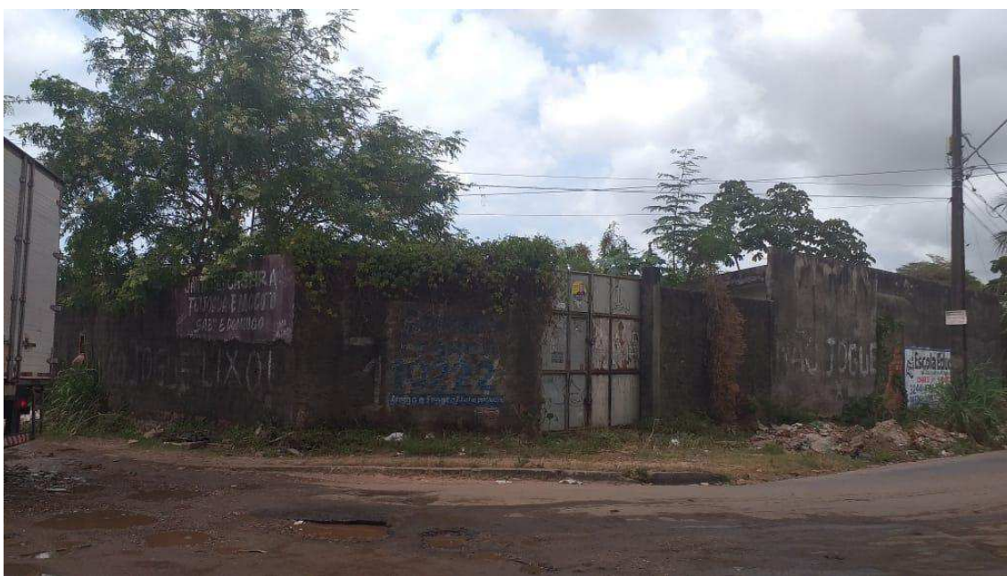
Foto 20 – Vista da esquina da Rua S com a Avenida Projetada – vistoria 24/08/2020
