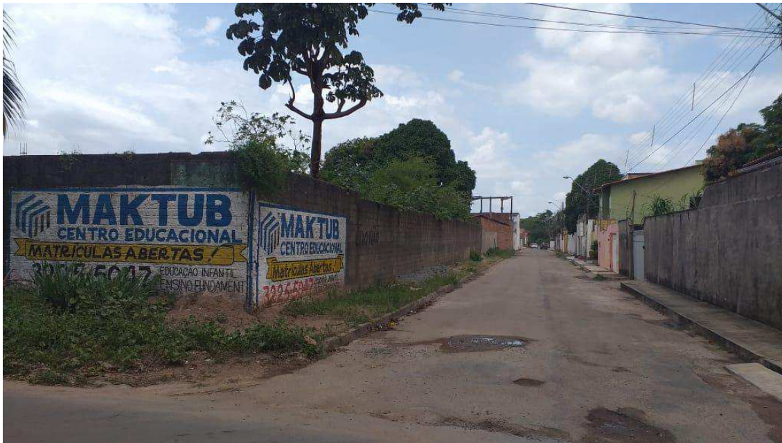
Foto 17 – Vista da esquina da Rua S com a Rua Seiscentos do Imóvel Avaliando – vistoria 24/08/2020
