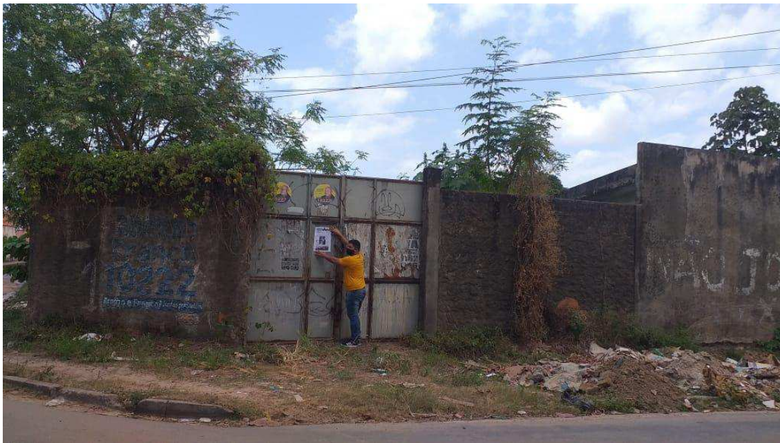
Foto 13 – Vista da esquina da Rua S com a Avenida Projetada – vistoria 24/08/2020
