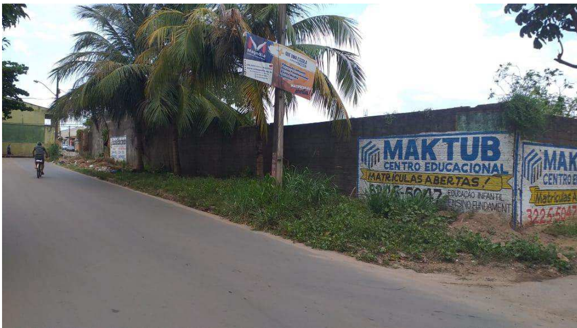
Foto 18 – Vista da esquina da Rua S com a Rua Seiscentos do Imóvel Avaliando – vistoria 24/08/2020
