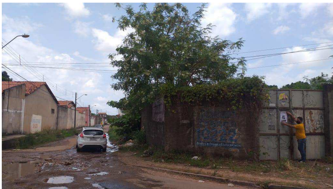
Foto 12 – Vista da esquina da Rua S com a Avenida Projetada – vistoria 24/08/2020
