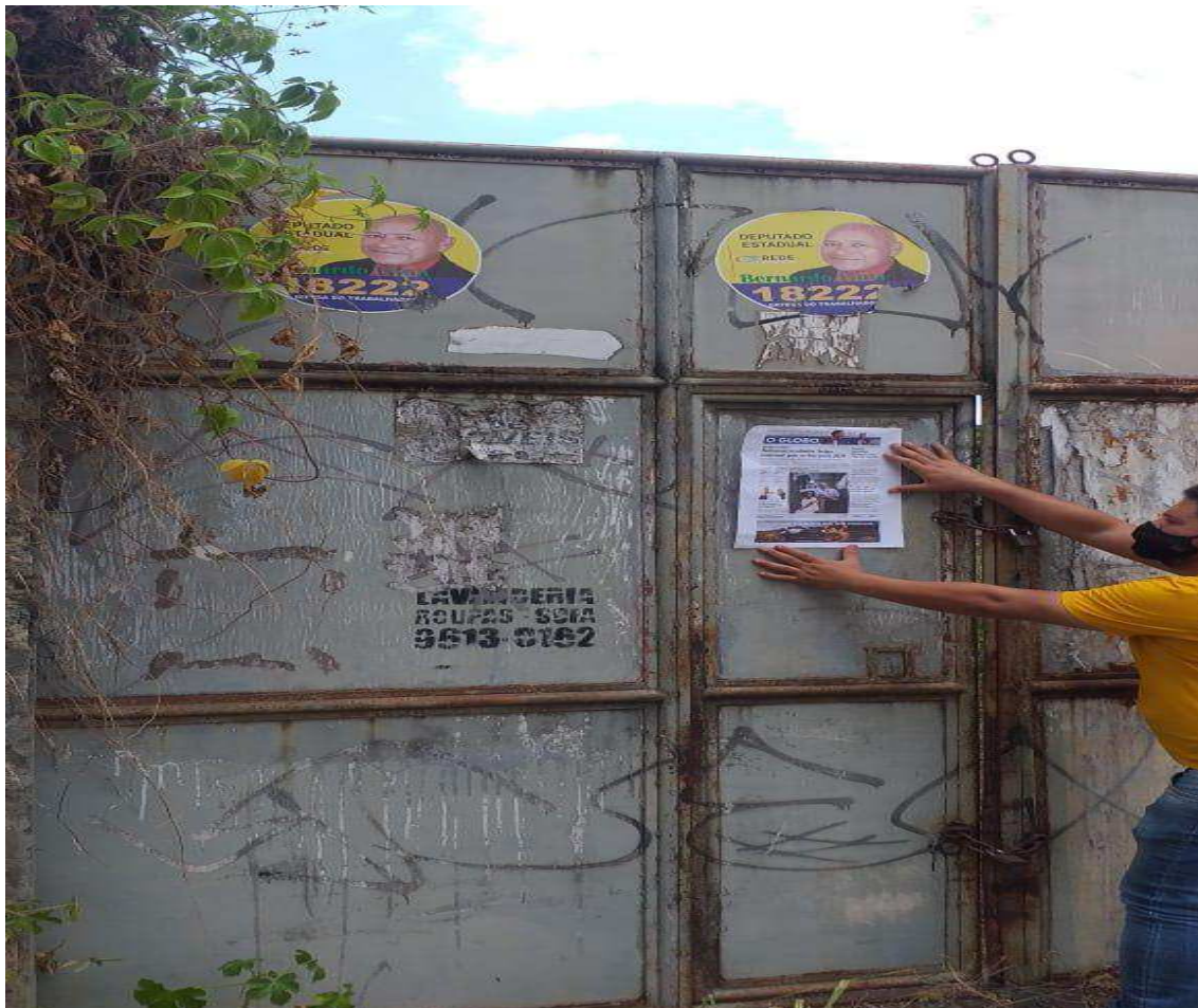
Foto 15 – Vista do portão de acesso ao lote limero ao imóvel avaliando – vistoria 24/08/2020
