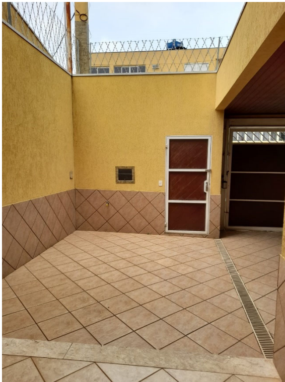
Fotografia 10 - Aspecto interno do imóvel avaliado.
