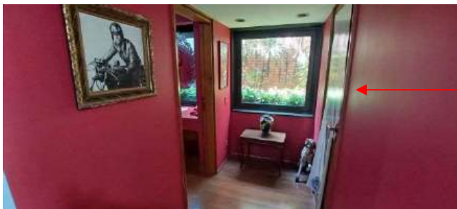
Saleta com sistema de ventilação do ar condicionado central
