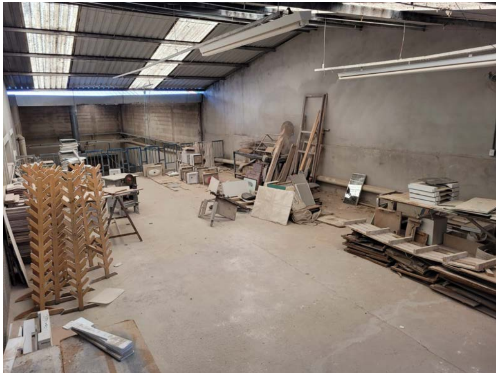
Fotografia 04 - Aspecto interno do imóvel avaliado.
