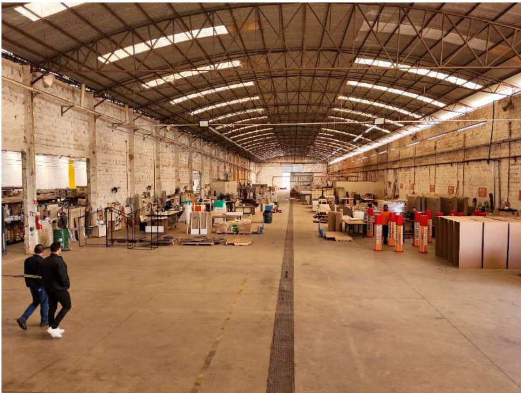
Fotografia 11 – Aspecto interno da construção existente.
