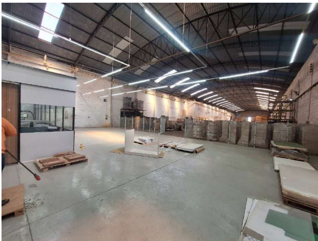
Fotografia 13 – Aspecto interno da construção existente.
