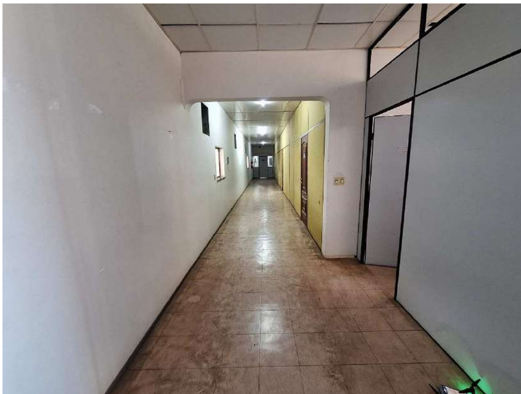
Fotografia 15 – Aspecto interno da construção existente.
