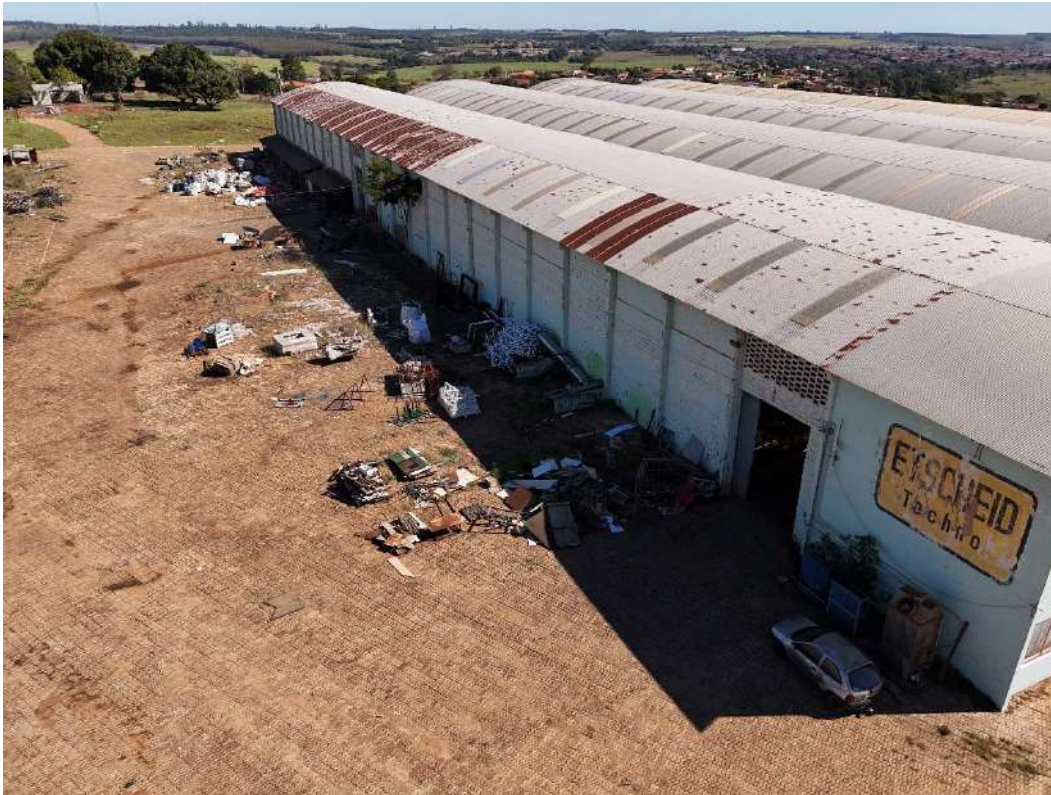
Fotografia 06 – Aspecto externo da construção existente.
