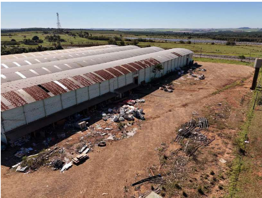
Fotografia 07 – Aspecto externo da construção existente.
