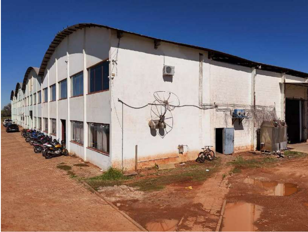
Fotografia 10 – Aspecto externo da construção existente.
