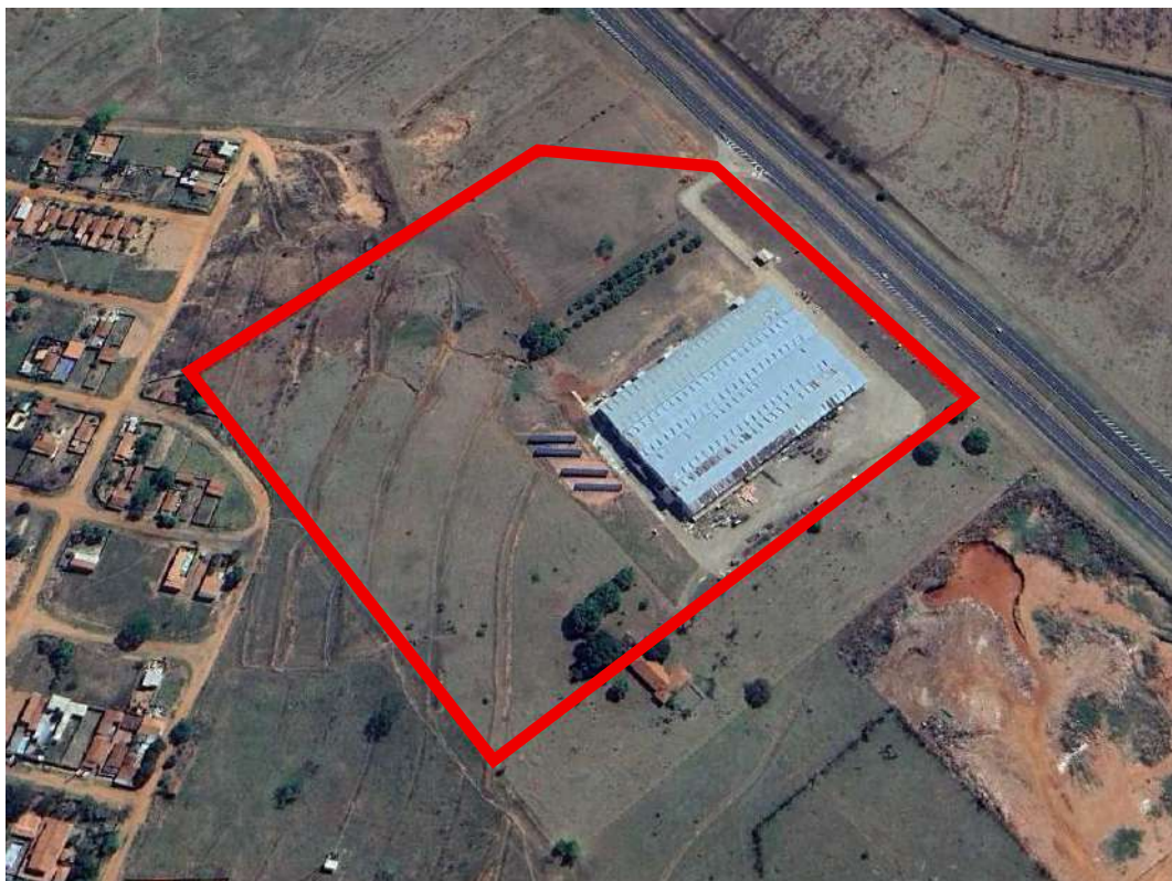
Fotografia 02 – Aspecto dos limites do imóvel avaliado (em vermelho).
