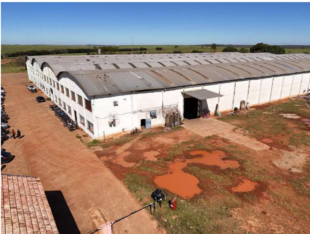
Fotografia 09 – Aspecto externo da construção existente.
