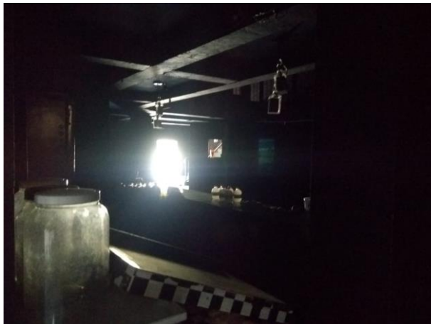
Características Internas do Imóvel Avaliando.
