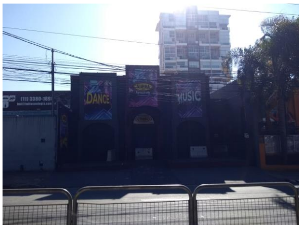
Vista Externa do Imóvel Avaliando.
