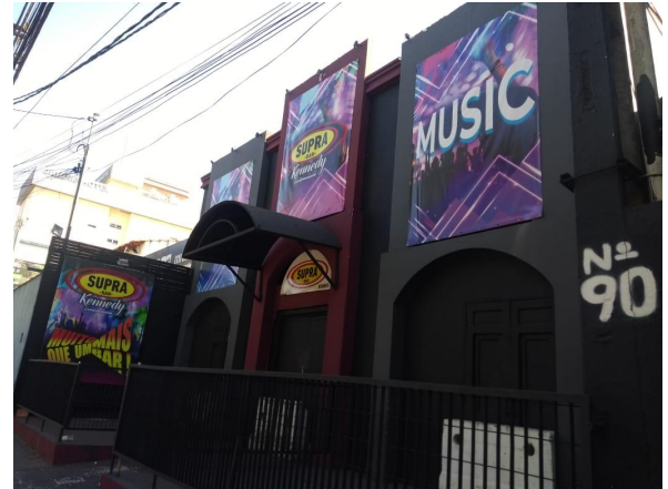
Vista Externa do Imóvel Avaliando.
